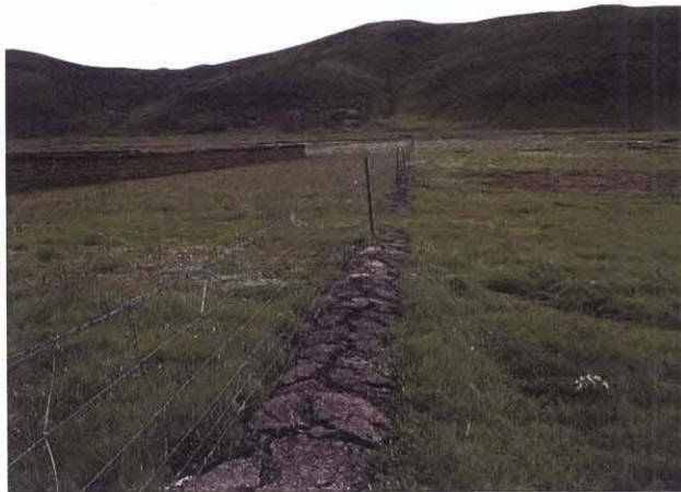
玉樹県・囲欄設置状況（夏場）
