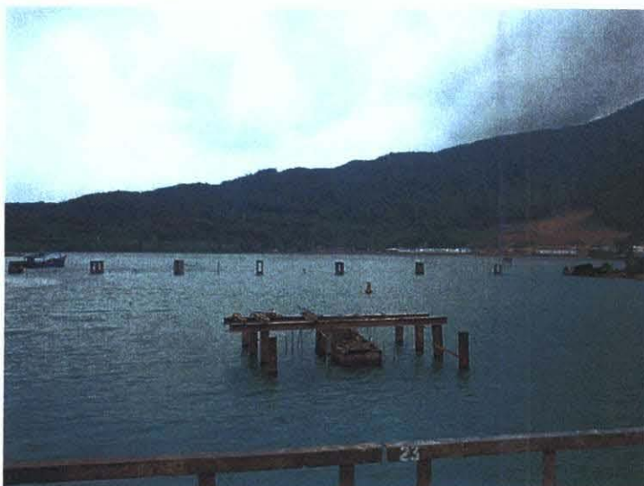
タンザンラグーン南部にあった橋脚も 1999 年洪水によって押し流された。現在、復旧作業が進められている。
