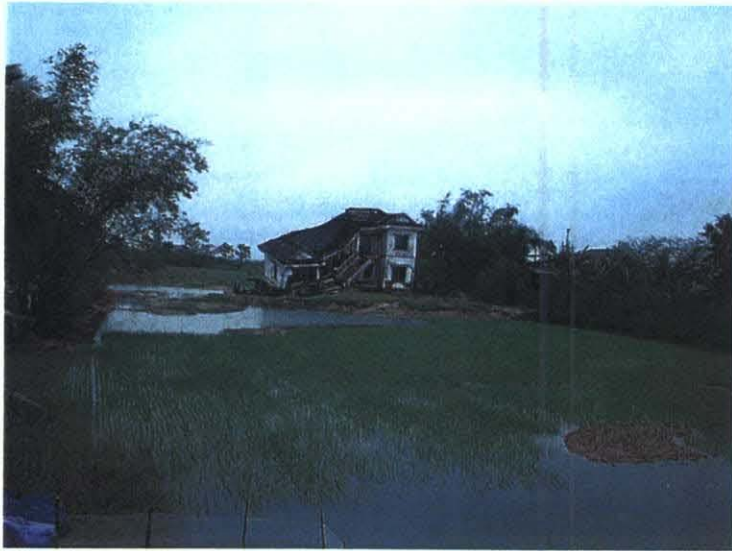
1999 年の洪水によりボー川支川の堤防が決壊した為、氾濫水の直撃を受けて倒壊した家屋
