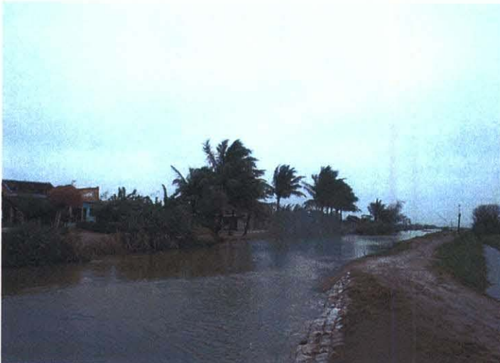
村落内を流れる水路 堤防が生活道路を兼ねているが、毎年侵食され、土嚢を積んで修理している。
