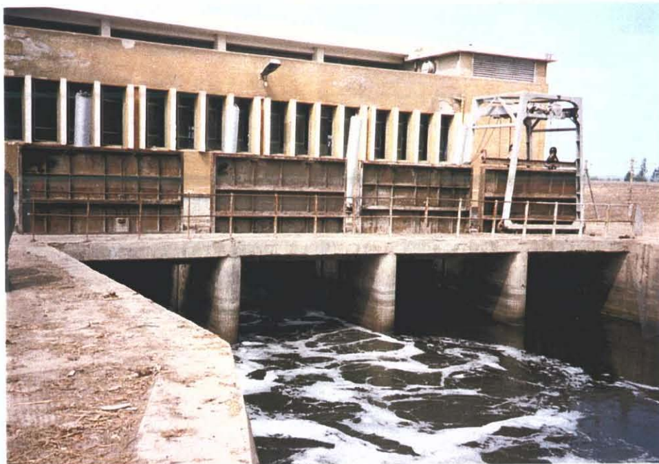
未処理都市下水の流入が多くポンプ材質選定への配慮が必要である
