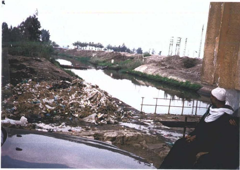
El Sadka 排水機场上流水路と都市廃棄物の流下が激しい
