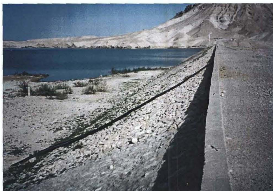
パルミラ近郊の灌漑ダム 灌漑省が建設
