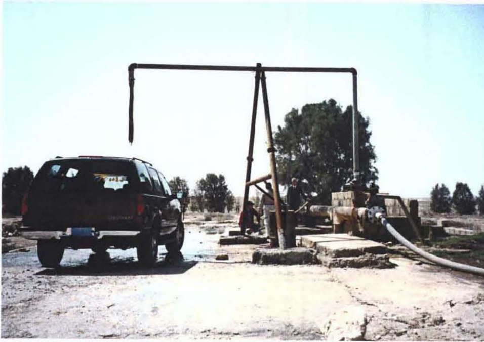
地下500mから45度の被圧温 水を取り、冷やして家畜の飲 み水に利用（ユオウの臭いが あり、人は飲めない）
