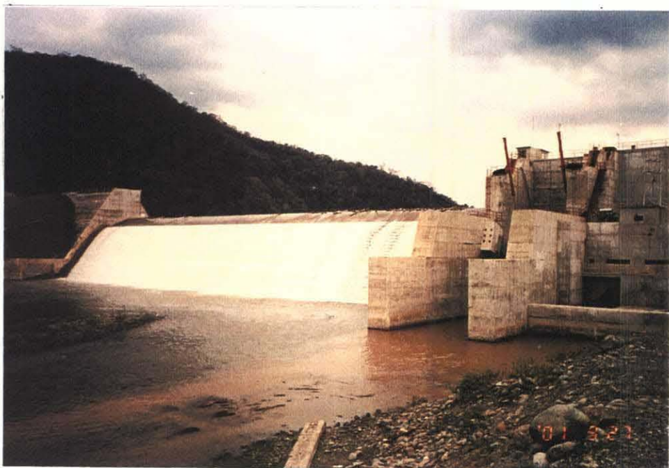
建設中の Moncion ダム下流の逆 調整池 (中流域)
