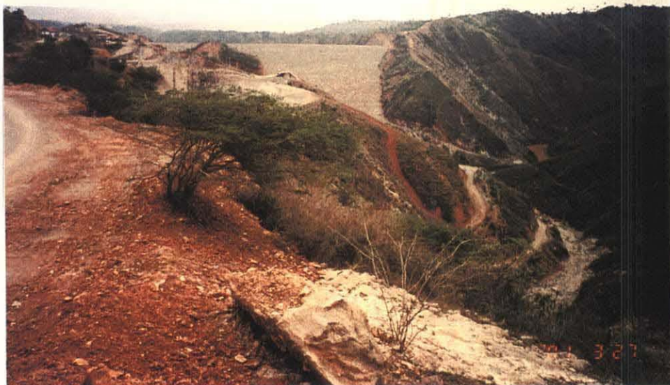
建設中の Moncion ダム ロックフィル型式、貯水量 3.7 億トン (中流域)
