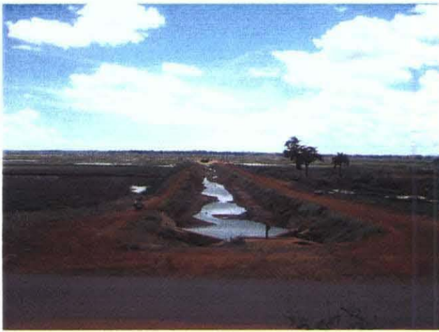
⑧ Amboromalandy 堰取水工より用水路を望む
