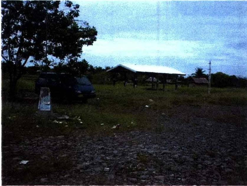
公共用地内に建設された公設市場施設
