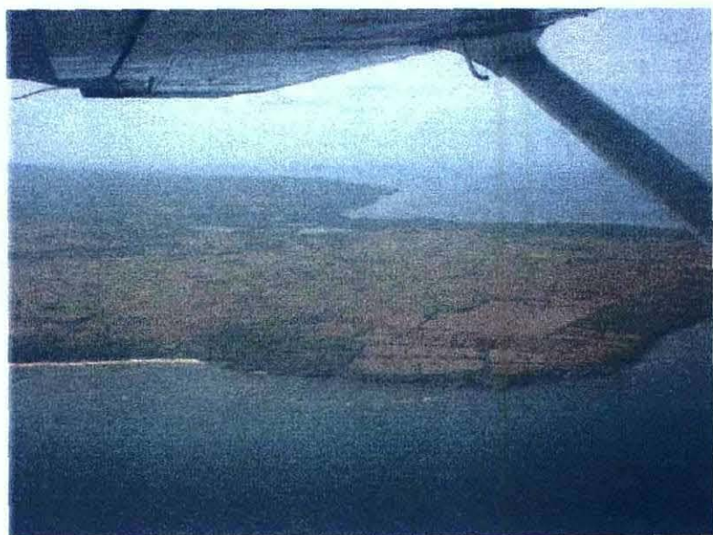
ルバング島北部の灌漑計画地域（乾期に水位低下により、灌漑用水がポンプアップできなくて、耕作不能になっている農地が多い）
