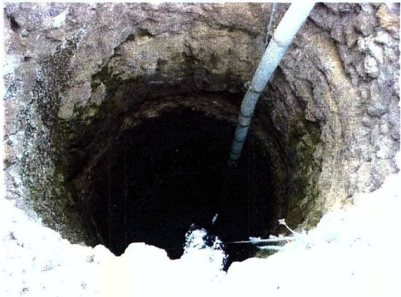
灌漑用の浅井戸（水位低下と揚水量不足のため乾期灌漑に使用できない）
