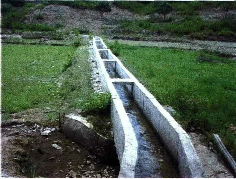
小規模灌漑による支線水路
