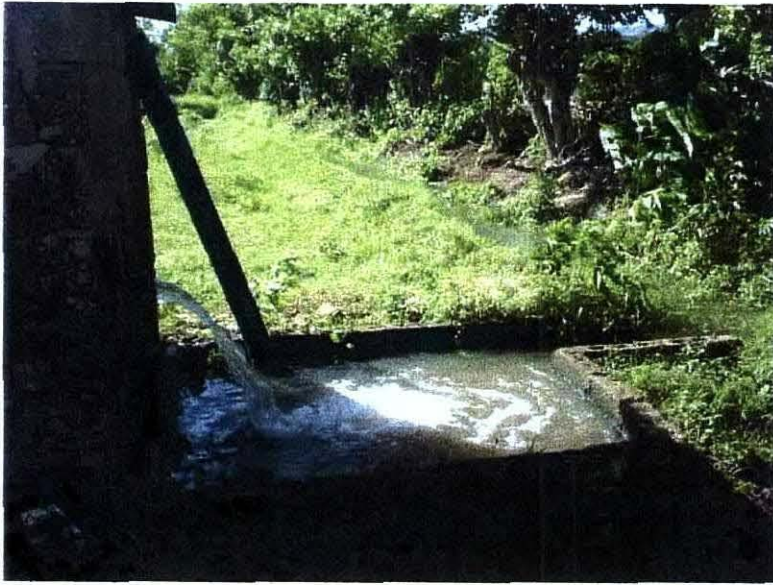
乾期灌漑中の小規模ポンプ場（地下水位の高いポンプ場のみ 乾期に運転可能である。）
