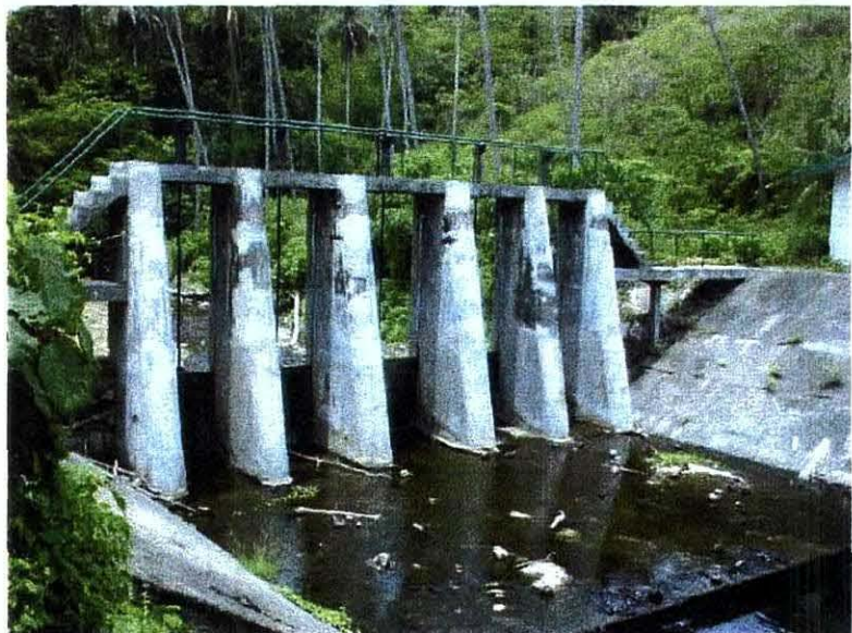
ルバング島に5ヵ所ある小規模灌漑システムの頭首工
