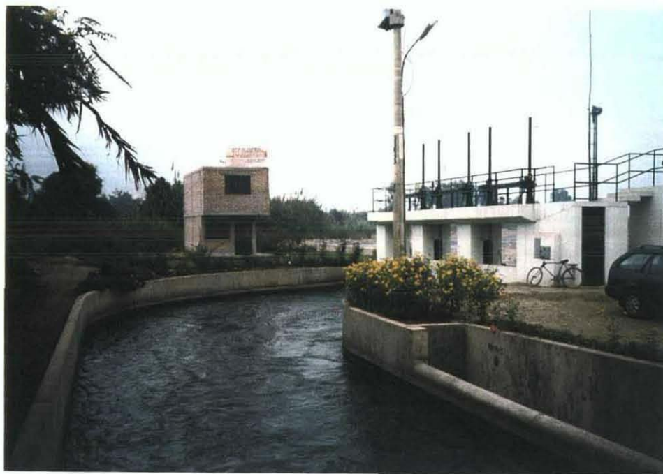
同上の取水施設
