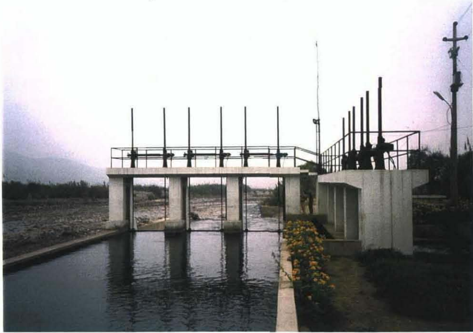
コスタ地域にある日本の無償資金協力で建設された頭首工
