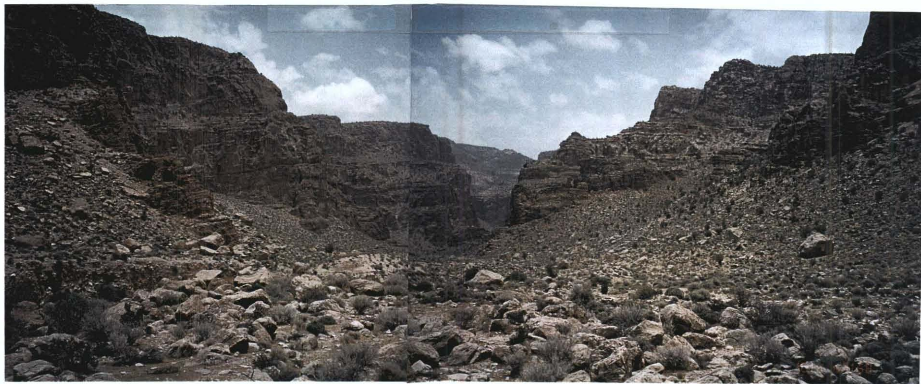
ファサ東南約 50km のロシャニーダム候補地点 両岸とも岩が露出していて地形的にはきわめて有利 但し、谷間は断層の恐れがあり今後の調査が必要である リチャージダムが適当と思われる
