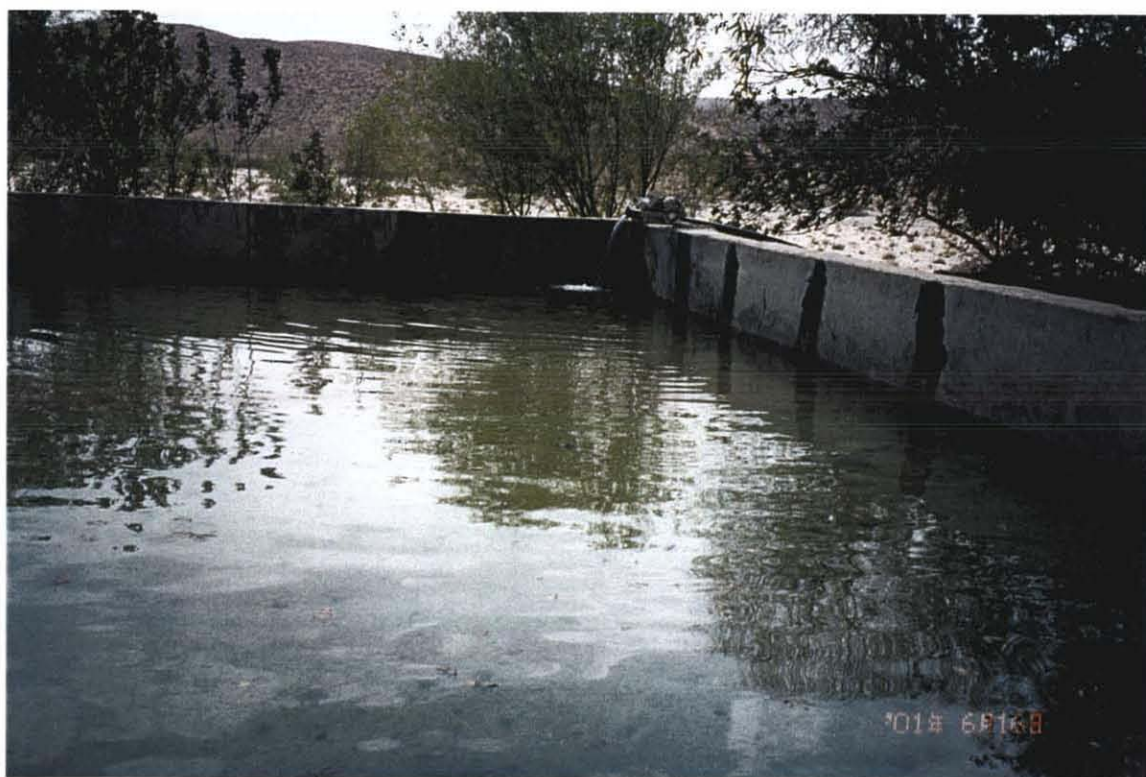
同上ポンプの吐出し口とファームポンド 吐出水量はポンプ能力の20%程度 (4" ポンプ)
