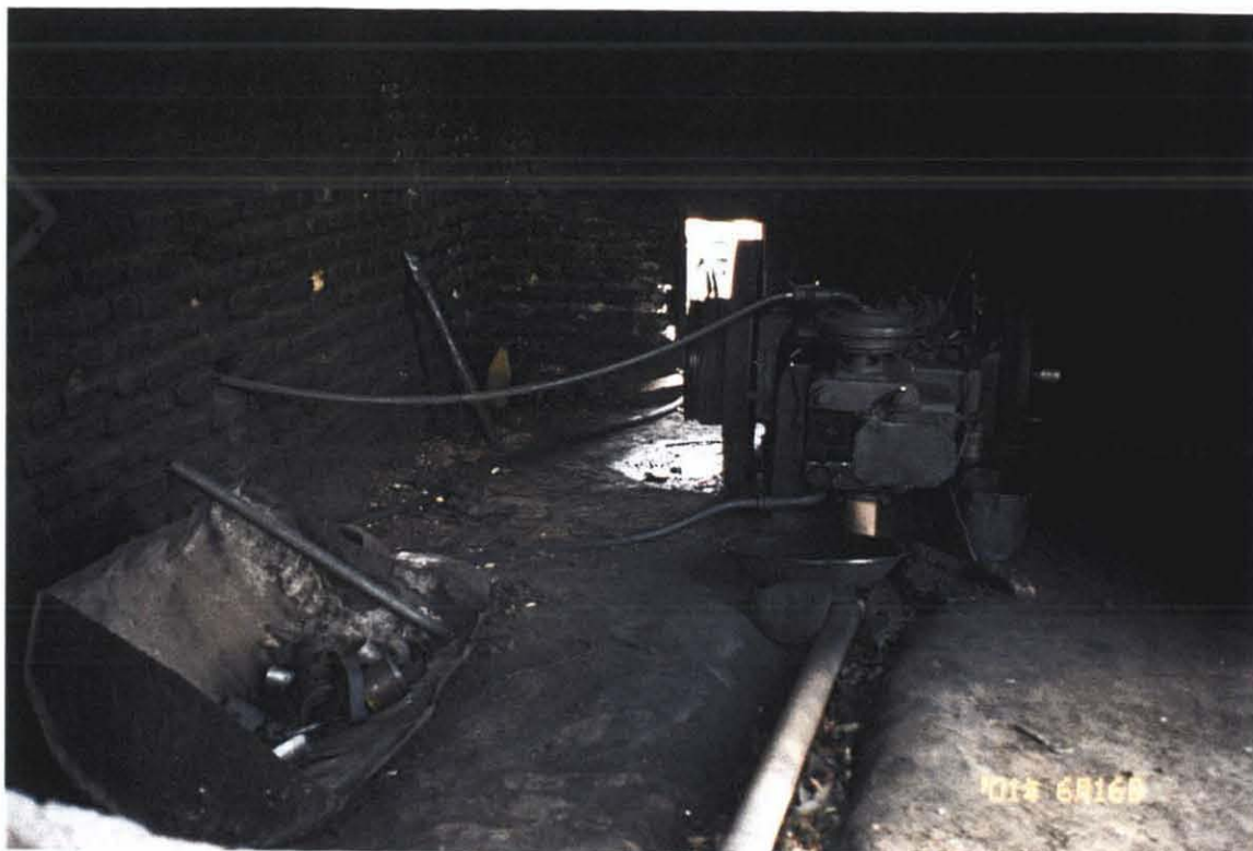
ファサ郊外の地下水汲み上げ用ポンプ場(ディーゼル発動機)
