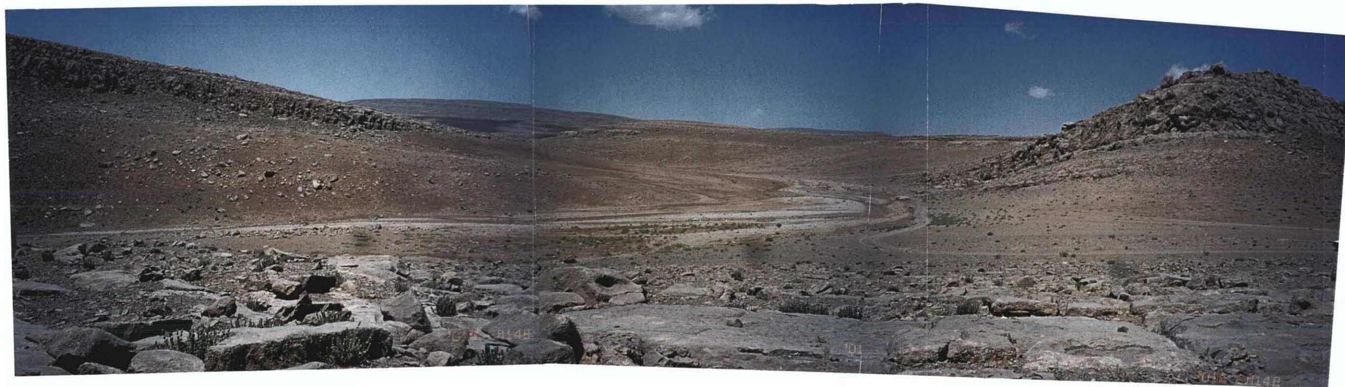
ファルス州バグ・モールドダム候補地 ダムサイトは基礎岩盤露出 水没域は全く未利用の荒地 堤長 150m, 堤高 15m, 貯水量 50 万 t の予定
