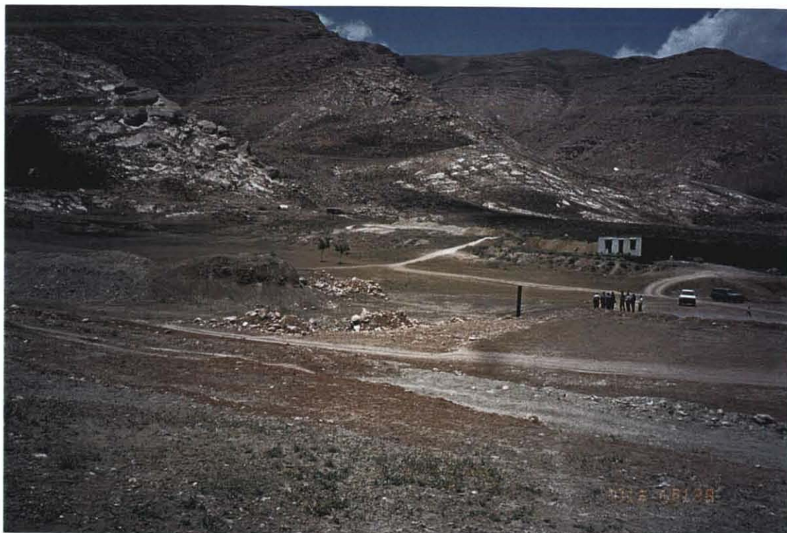
ノーラックファームポンド 築堤着手したばかり 堤長 350m, 堤高 18m, 貯水量 35 万 t の予定
