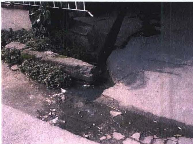
家庭雑排水を流す水路。農家の庭先から道路側溝に排水している。道路側溝も十分管理されていないため、汚水が側溝を溢れて、道路上に流れているところもある。乾期には悪臭も元にもなる。また、水溜まりは、マラリヤや Dengue 熱を媒介する蚊の幼虫、ボウフラの絶好の棲息環境を提供することになる。
