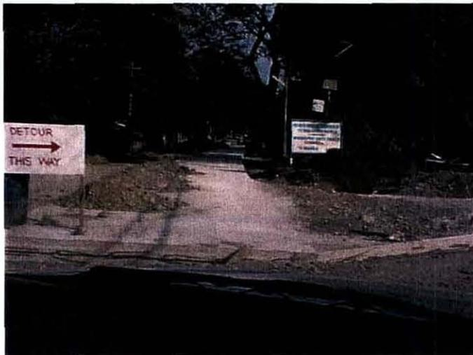
パンガシナン州の基幹道路は比較的良く整備されている。主な国道、県道はほとんどコンクリート舗装やアスファルト舗装されている。しかし、農道はまだまだ整備水準が低く、農民は生産投入資材や農産物の搬出入に苦勞している。写真は市町村道級の道路で、現在コンクリート舗装工事中である。コンクリートはフィリピンでセメントが生産でき、維持管理費が安価であることから道路舗装材として広く用いられている。
