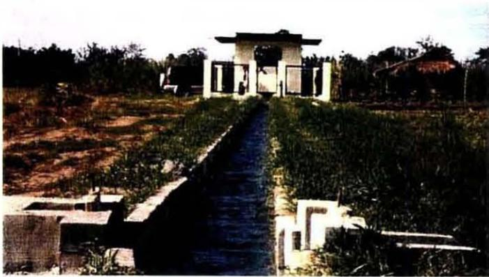
ポンプ灌漑システム。ポンプ場からの幹線用水路と分水口。水路からの漏水を防止するため、幹線用水路はコンクリート舗装されている。
