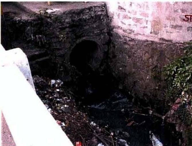
農村部の污水状況。下水道施設がなく、農村部では家庭雑排水は道路側溝などに未処理のまま排水している。側溝は河川に接続しているため、ラグナ湖に流入する河川の水は汚染されている。
