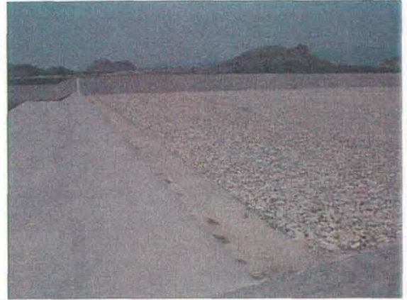
タイトル: ワジ・ジジ ダム 日付: 010720 記述: 右岸洪水吐け。
