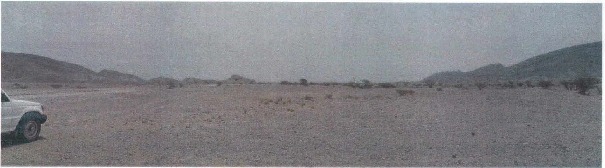
地下ダム：副ダム候補地、(アダム集落の西方、上流からダムサイトを望む)
