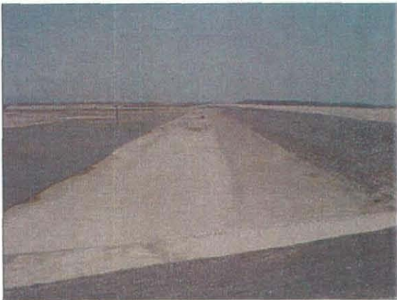
タイトル: ワジ・ジジ ダム 日付: 010720 記述: 貯水池。右岸より。
