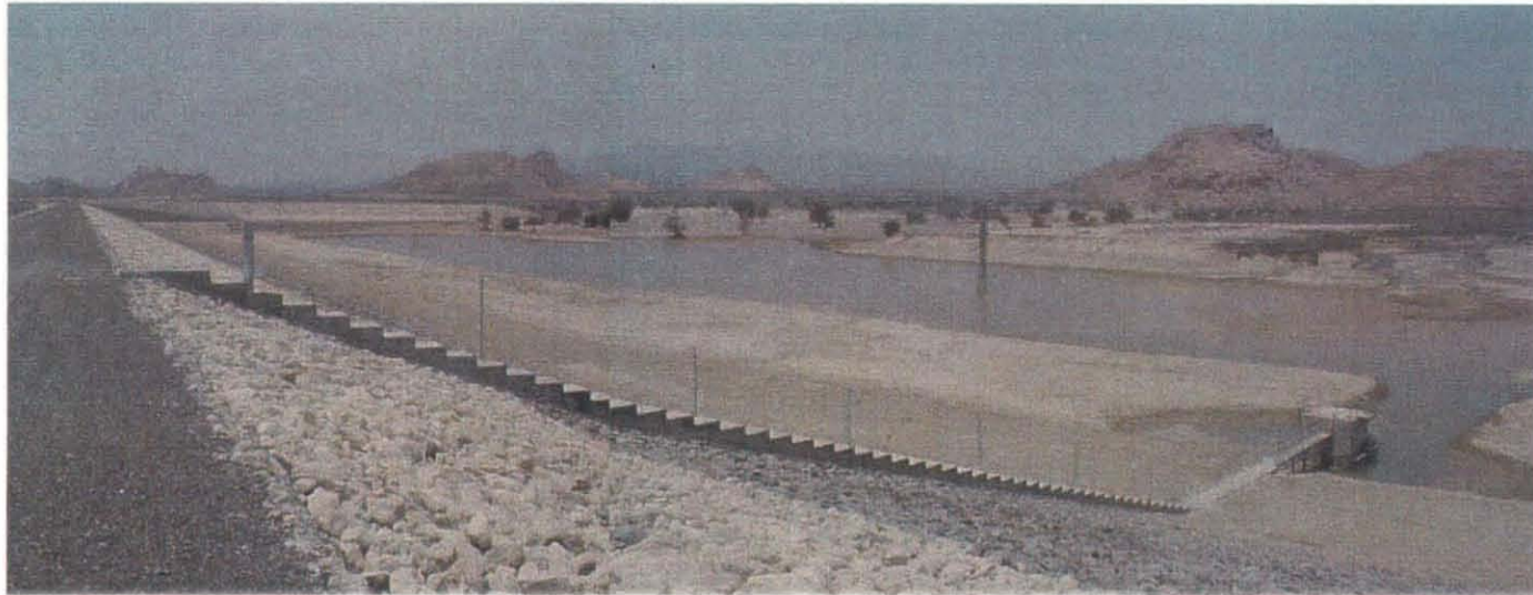
ワジ・ジジ ダム (貯水池は数日前の 降雨のため水が残る)
