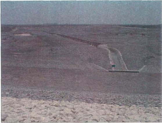
タイトル: ワジ・ジジ ダム 日付: 010720 記述: 堤体から下流を望む。
