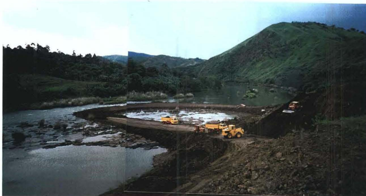
アダラム灌漑計画のダムサイト、基礎掘削中
