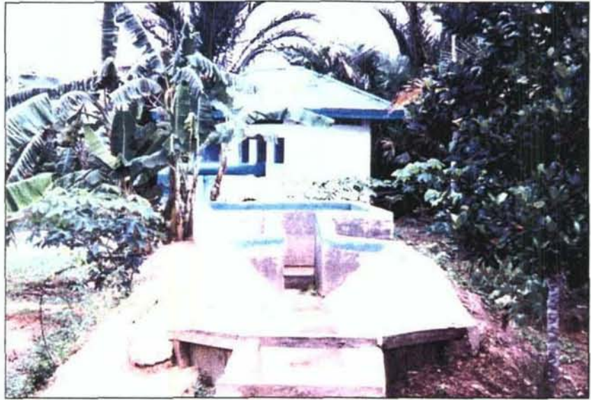
完成地区の一つ：ポン プ場、吐出し水槽、幹 線用水路
