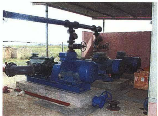
ベンゴ川導水路に設置されたポンプ小屋
