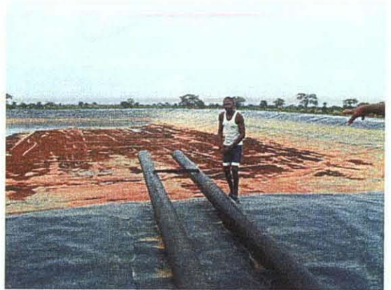
ラバーシート処理された貯留池
