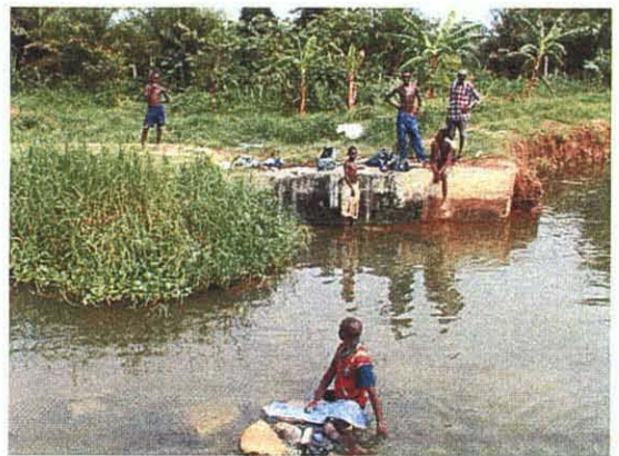
ベンゴ川に建設された自然取水口
