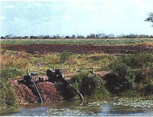
幹線水路(8.8km地点)
