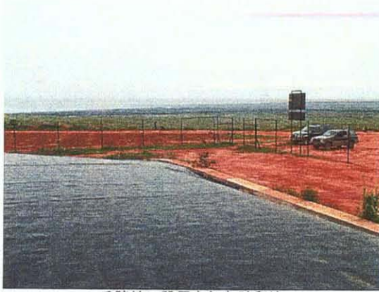
丘陵地に設置された貯留池
