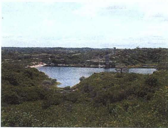
上流の既存ダム (キニーナ貯水池)
