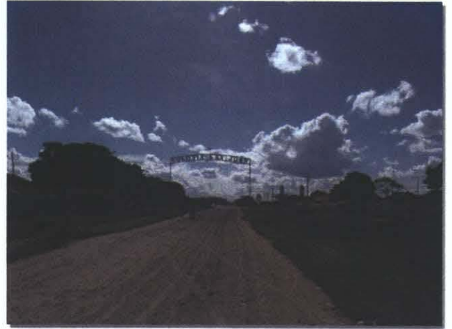
国道とサンファン移住地を結ぶ幹線道路◆ 無償資金事業で舗装工事实施中（2002年8月完成予定）
