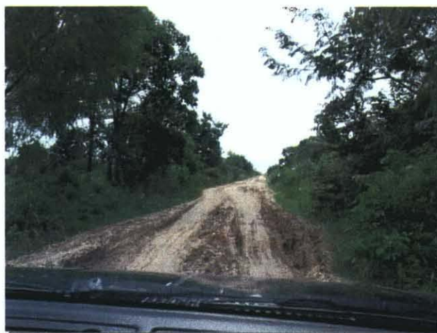
◆未整備のため通行困難な農道
