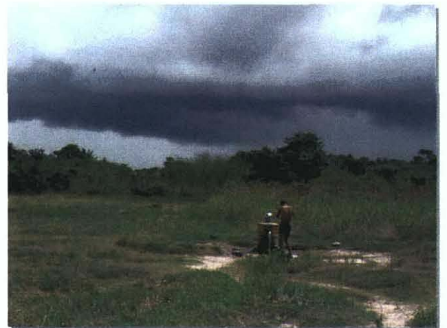
アントファガスタ移住地の ◆ 共同水道施設
