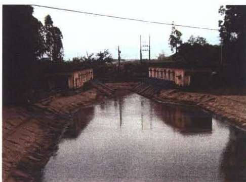
ボース揚水機場
