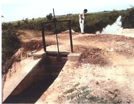
既存灌漑施設
