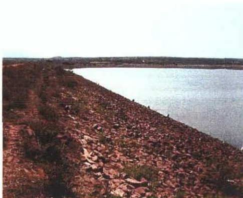
計画地区周辺の既存貯水池
