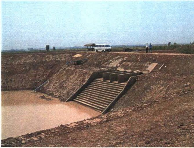
ヨム川左岸の Nong Yan Yao。貯留能力増進のために改修工事中。周辺堤防に設けられた洪水流入樋管。湖沼の上流部に3箇所設けられている。
