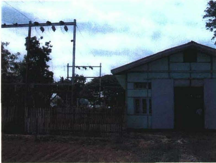
施設は 1991 年に I D A 援助で建設されたモンワ地下水灌漑施設の変電所
