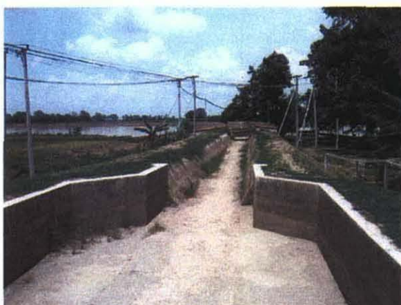
沈砂池と用水路
