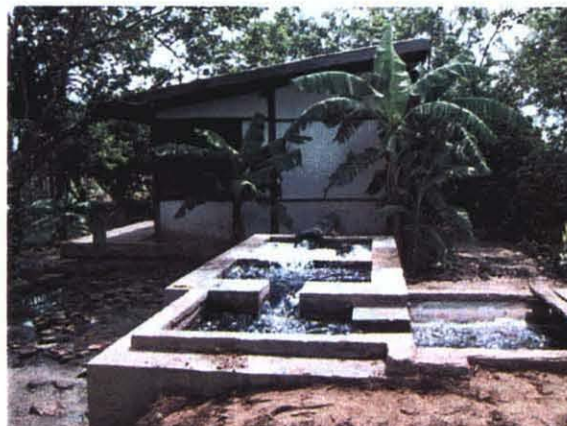
モンワ県での地下水ポンプ
