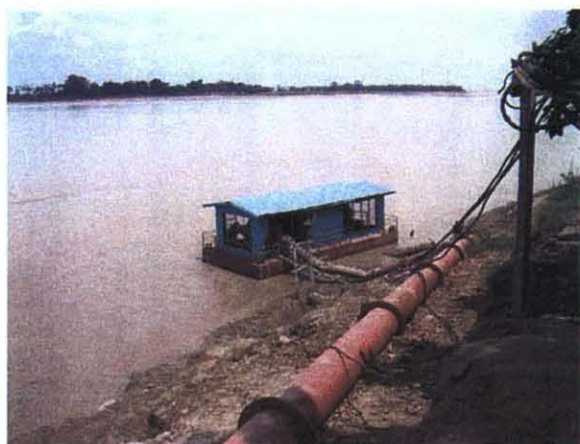
フローティング式揚水機場
