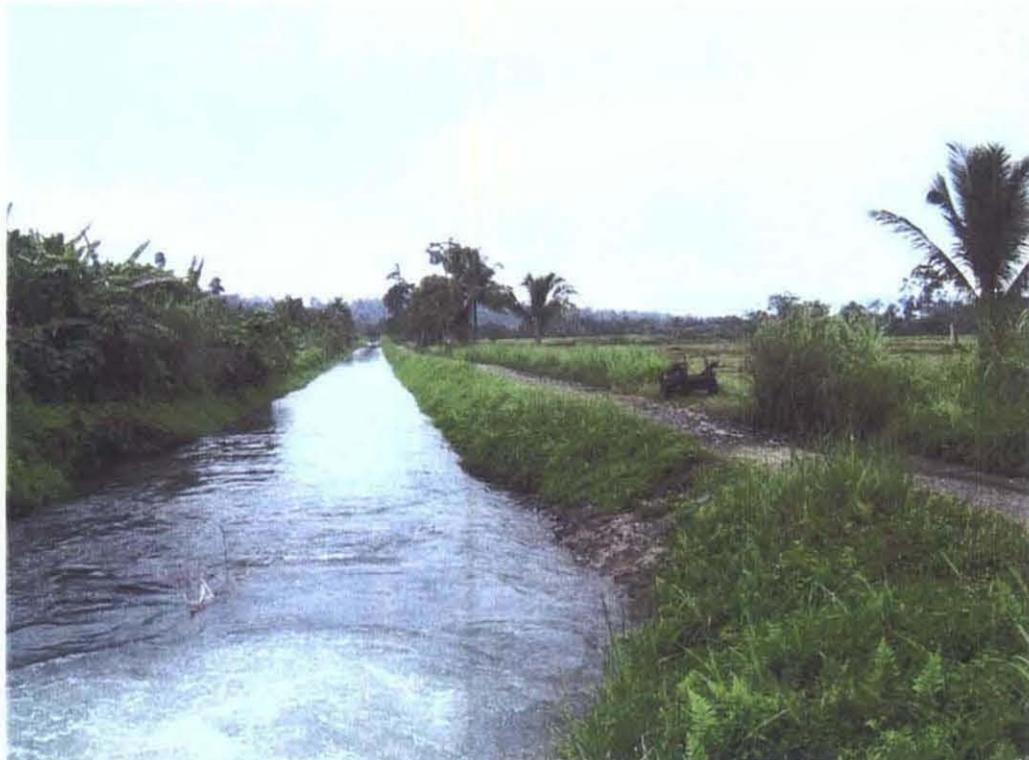
左岸幹線水路：分土工下流の法面が洗堀されている
