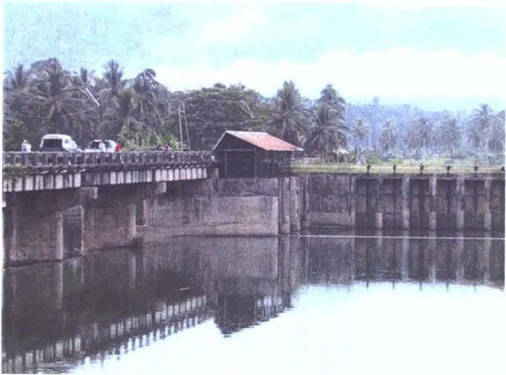
タゴ川頭首工：右岸側取水工と右岸側土砂吐
