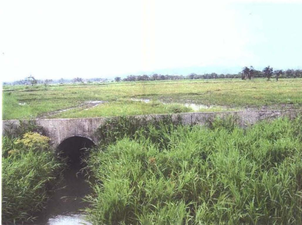
右岸幹線水路：最下流のパイプラインの分水工
