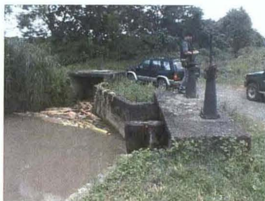
対象地域支線水路分水工
