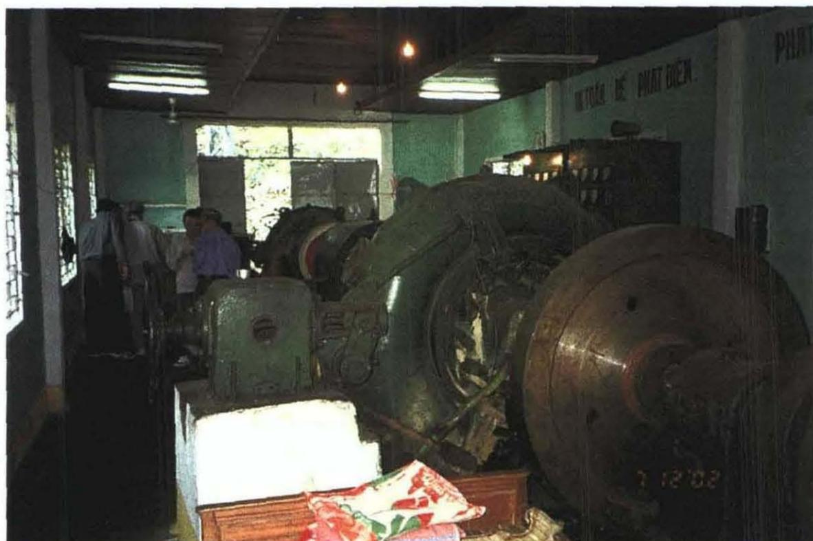
Dak Sa 発電所 手前が故障中の 400kw のユニット。奥が 200kw ユニット (運転中)。
