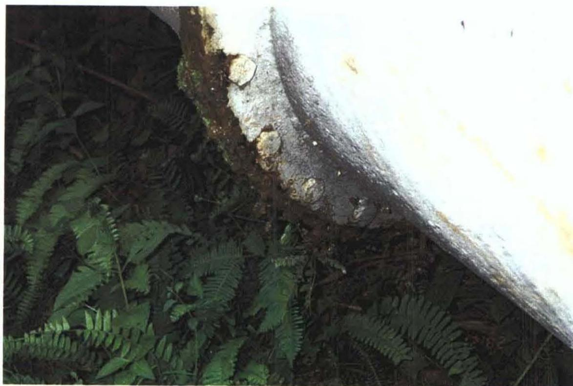
水圧鉄管継ぎ目からの漏水。
