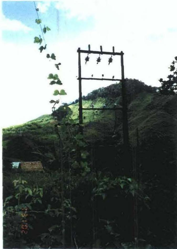
発電所用変電所 10.5kV で送っている
