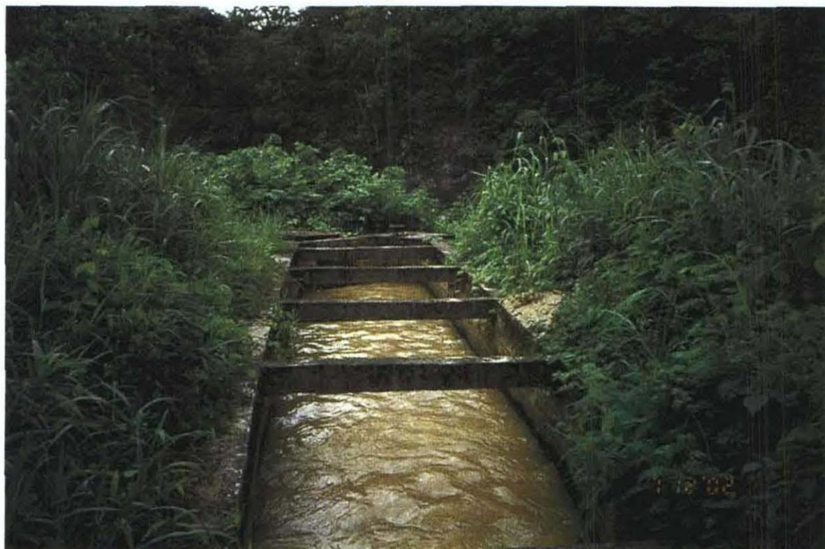
Dac Sa 発電所 沈砂池 奥に排砂ゲートが見える。
