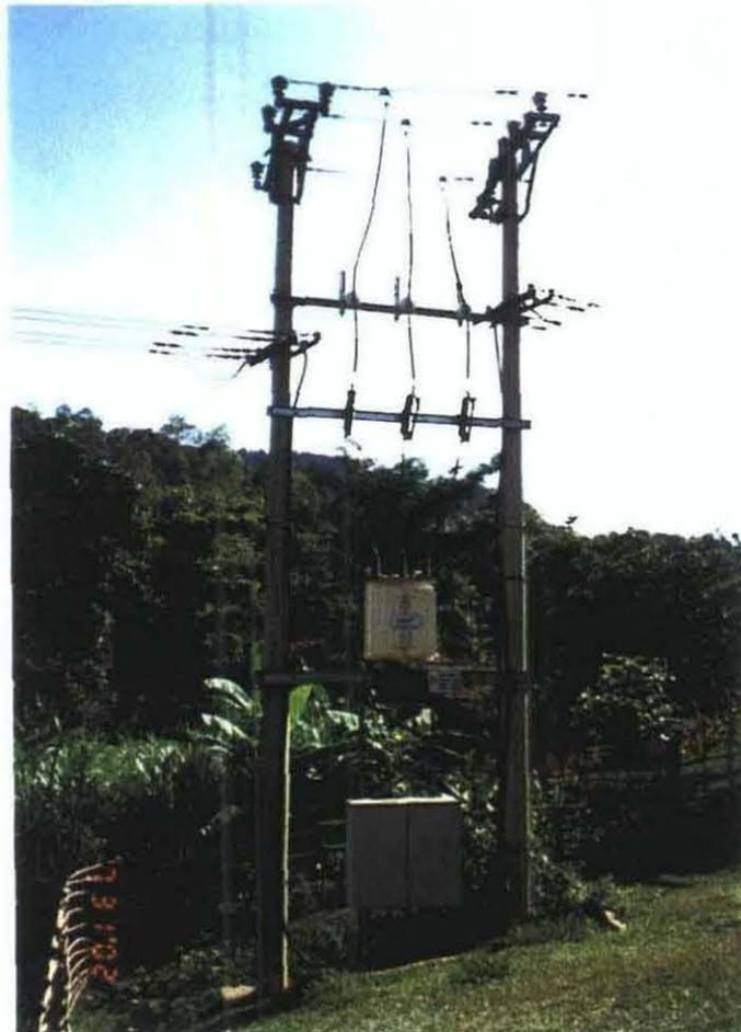
ヒエン人民委員会への途中 砕石場近くの小変電所.中央部は 22kV 変圧器 下は 400/220V 低圧分電箱
