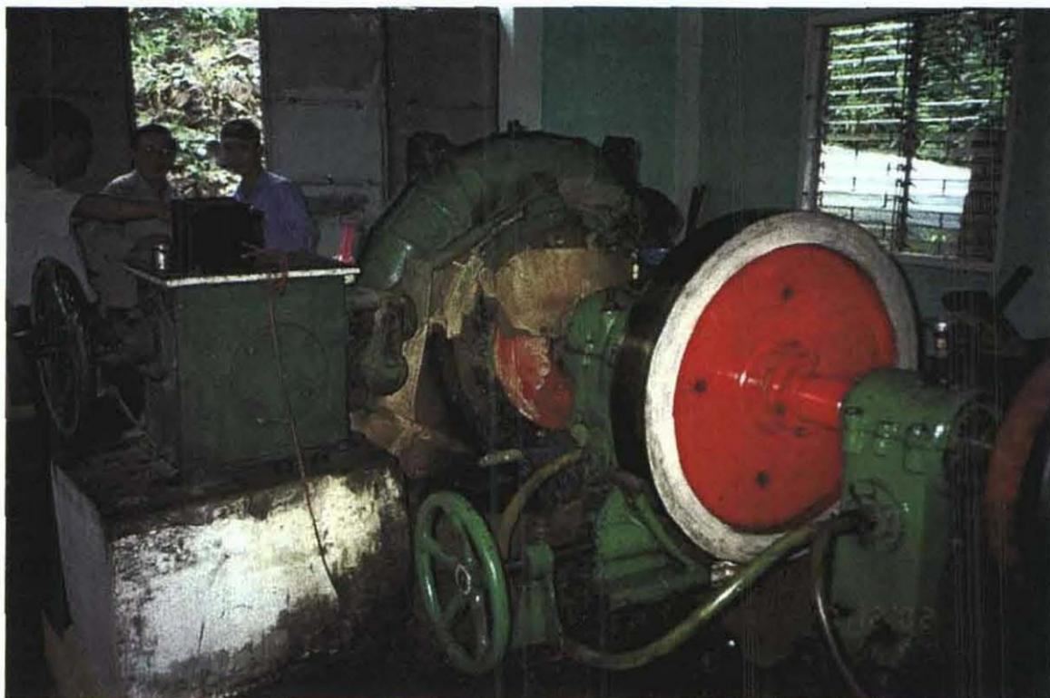
Dak Sa 発電所 200kw ユニット。横軸フランシス型水車。運転中であるが軸受けからの漏水が激しい。
