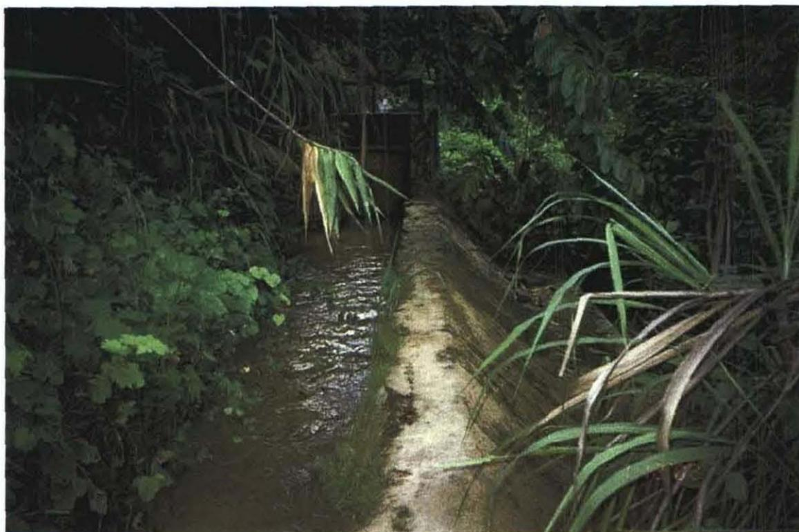
Dak Sa 発電所 余水吐 奥に制水ゲートが見える。
