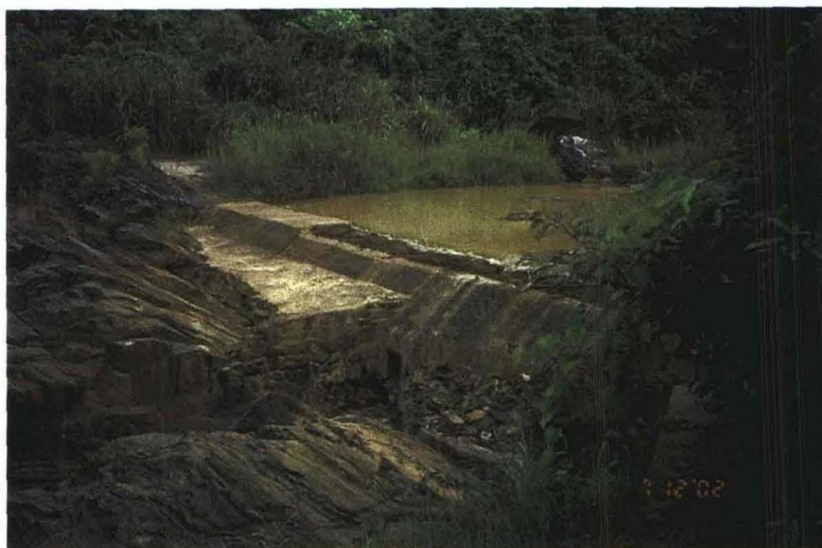
Dak Sa 発電所 取水ダム及び取水口（チロリアンタイプ） 越流部のトップに呑み口があり、堤体内の水路を流れ導水路へ続く。
