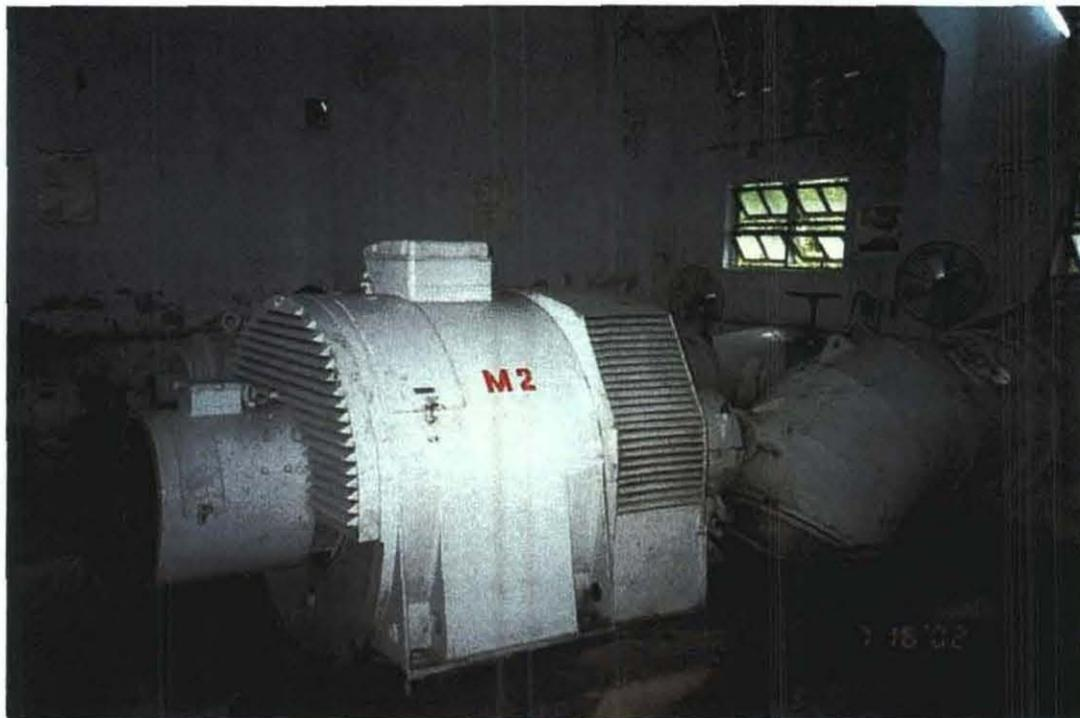
手前が 360KW ユニット (ドイツ製カプラン水車)。実際の出力は 320KW。奥は 210KW ユニット (ハンガリー製カプラン水車)。実際の出力は 130KW。
