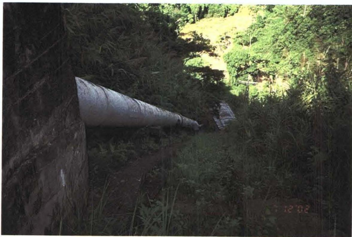
Dak Sa 発電所 水圧鉄管 (φ600mm) と発電所。落差 60m。送電線も見える。(Quang Nam 省 Phuoc Son)
