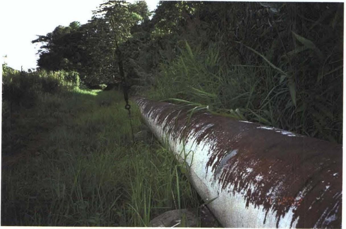
Dak Sa 発電所の水圧鉄管による導水路部分 (Quang Nam 省 Phuoc Son)
