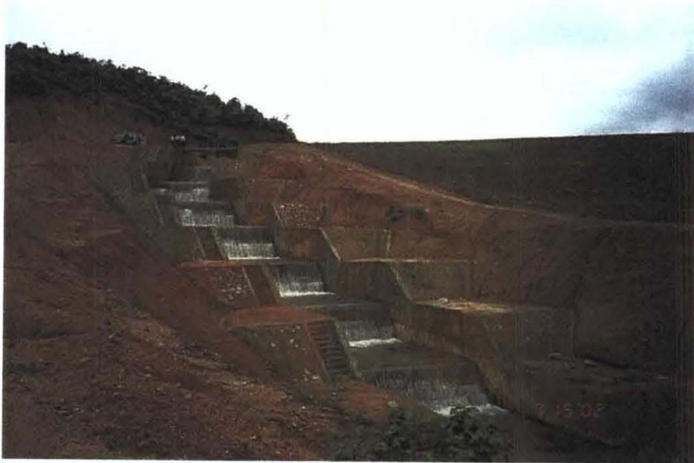
灌漑用設備の遊休落差。ダム右岸側に設置された放水路の遊休落差を利用して発電が可能である。
