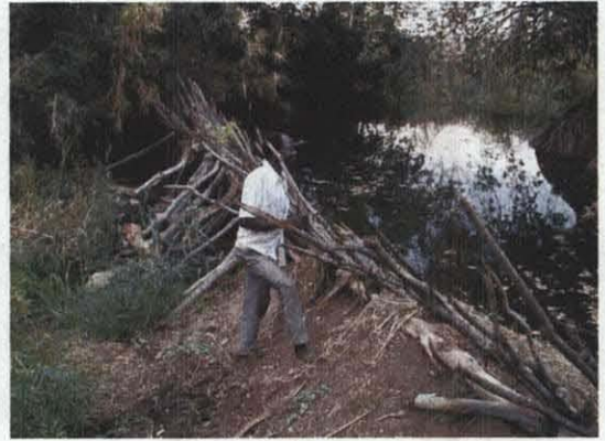
Liwadzi グループが設置した簡易な堰
