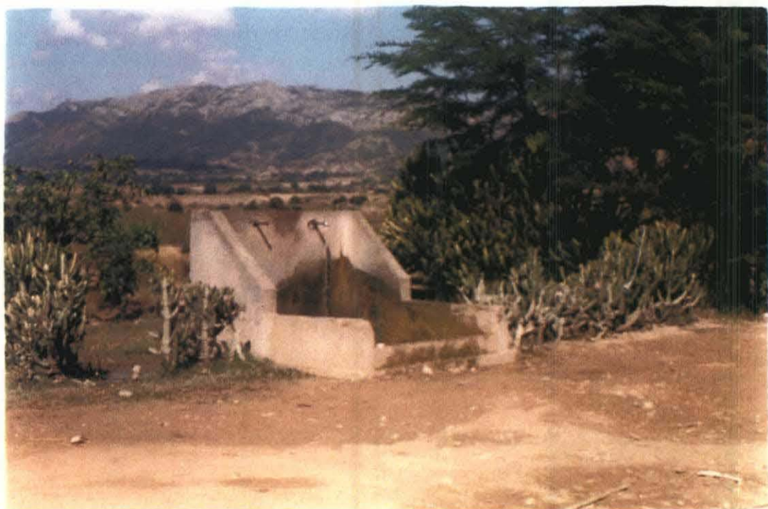
共同水栓（生活用水）
