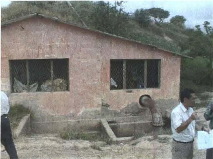
地区内 2次揚水機場
