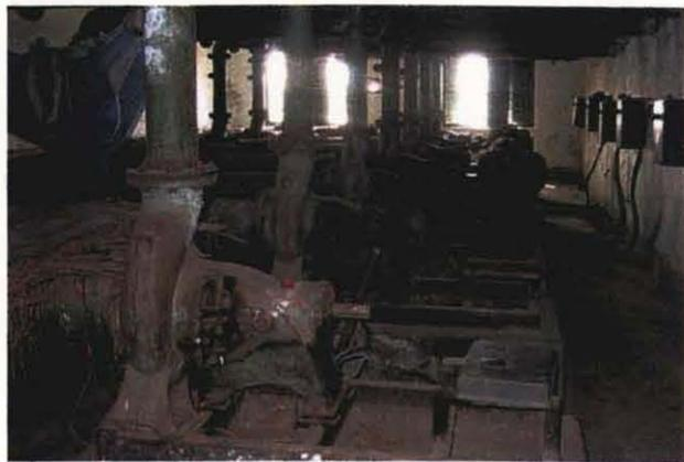
モーターが損傷しているポンプ場 (Block 6)
