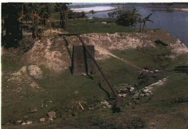
破損した水管橋 (Block 5)
