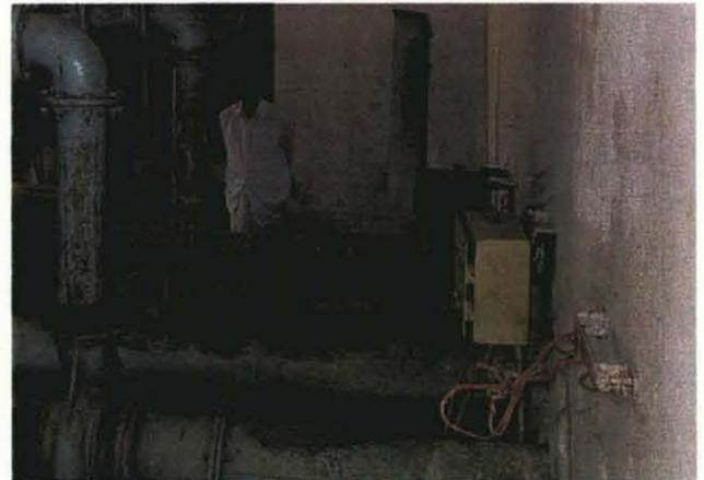
スイッチボックスが損傷している機場 (Block 1)
