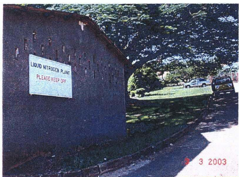
18.11 第 2 液体窒素プラン ト棟、NAGRC&DB-エンテベ
