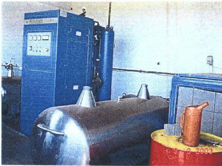
18.13 液体窒素製造装置、 SULZER LIQUID NITROGEN GENERATOR MODEL LINIT 10、NAGRC&DB-エンテベ
