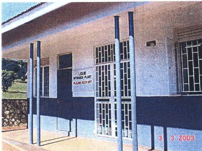
18.10 精子銀行棟内液体窒 素プラント室、NAGRC&DB- エンテベ
