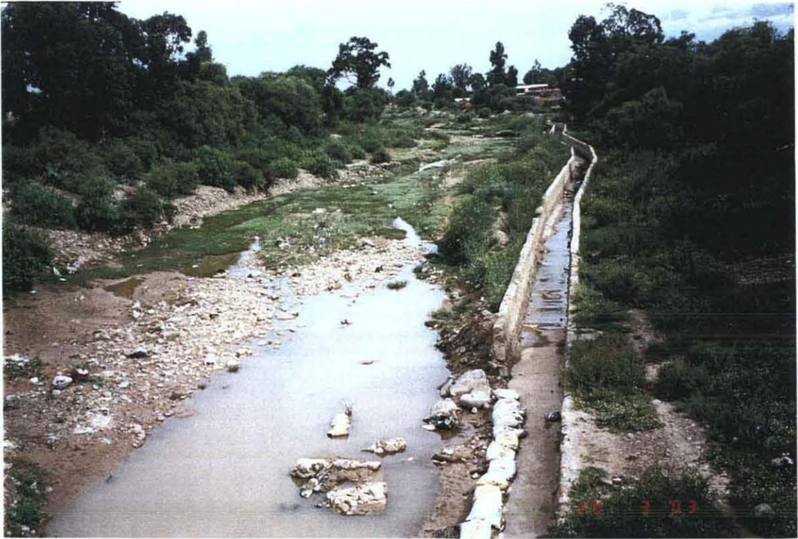
中央幹線水路：上流の下水混入区間を閉鎖し、直接河川より途中取水されている。
