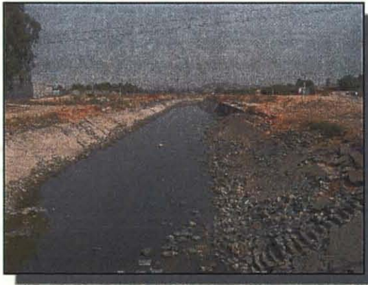
<トゥンガバドゥラ灌漑近代化計画> 左岸側低位幹線水路 ライニングが崩壊している
