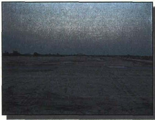
＜サンガンバンダ溜池灌漑開発計画＞ 堤体基礎部（盛土前）
