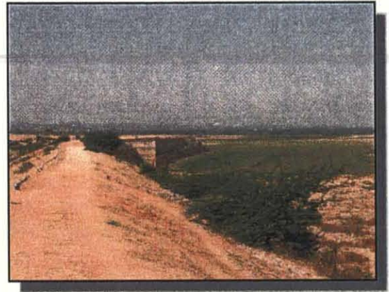
<ビマポンプ灌漑開発計画> Lift-II Shankara Samdram 調整貯水池 (既存) 写真右手が貯水池側
