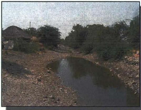
<トゥンガバドゥラ灌漑近代化計画> 左岸側低位幹線水路の支線水路 水路断面が不規則に拡大している
