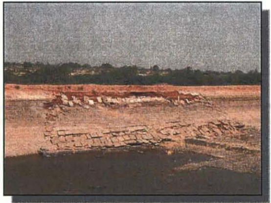
<トゥンガバドゥラ灌漑近代化計画> 左岸側低位幹線水路 ライニングが滑落している
