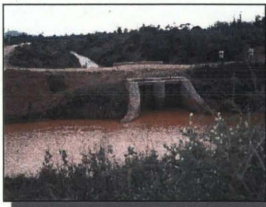
<トタパリ灌漑近代化計画> 既存左岸側水路取水口
