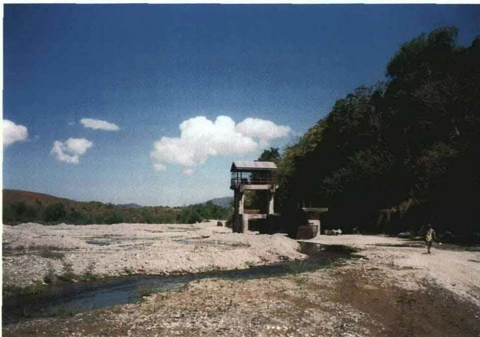
Nueva ERA NIS (Irocos Norte)、土砂が堆積し、堰が埋設してしまっている。
