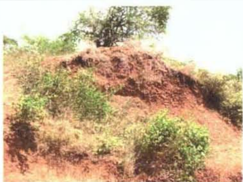
崩壊したため池
