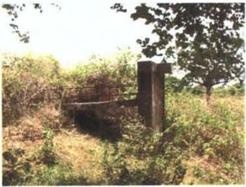
崩壊した灌漑施設
