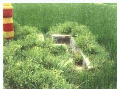
地下水灌漑施設
