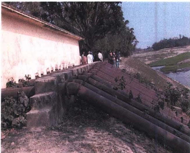
1960年代に北西部地域の河川で **Low Lift Pump Scheme** により建設されたポンプ施設。近年ポンプ施設の老朽化が進んでおりサクシオンパイプの一部も消失している。
