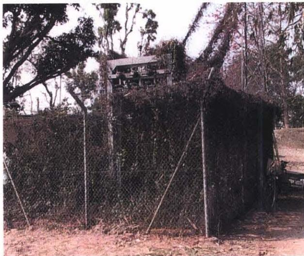
機能停止状態の変圧器。変圧器やコントロールパネルの電気系統についても、現在では部品の補充が不可能となっているため修理ができなくなっている。
