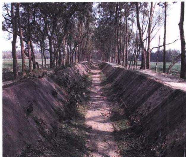
ポンプ施設の故障、取水口の堆砂などで取水ができなくなり、利用されていない幹線水路。早急にポンプ施設のリハビリが実施され灌漑用水が配水されることが待たれている。
