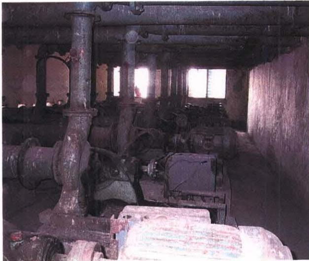
ポンプ施設の多くは建設後 30 年以上を経て老朽化による損傷が多く灌漑稼働率が著しく低下している。ポンプ、モーターの更新、ポンプ小屋の立替が必要である。
