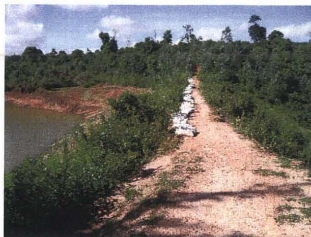
溜池の堤体上部 越流防止のために土囊が積まれている
