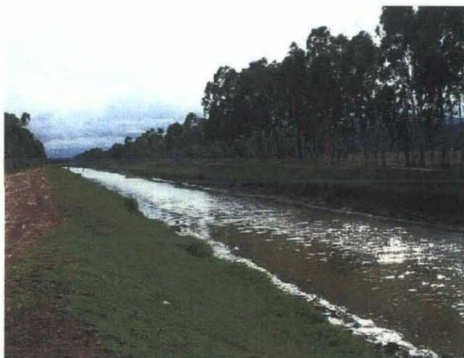
タックニャム灌漑システムの幹線水路 水路内法面の浸食が見られる
