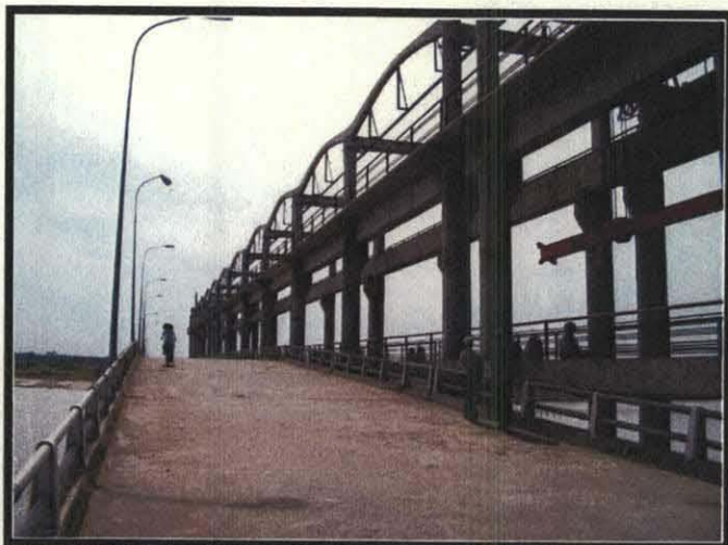
塩水遡上を防止する目的で設置された水門のひとつ
