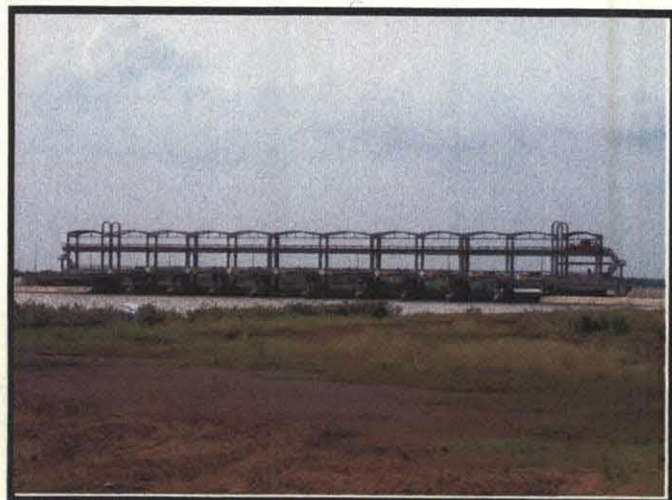
塩水遡上を防止する目的で設置された水門のひとつ
