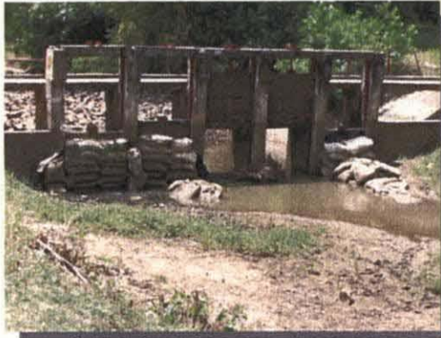
幹線水路に設置されている取水堰 ゲートの付け替えが必要
