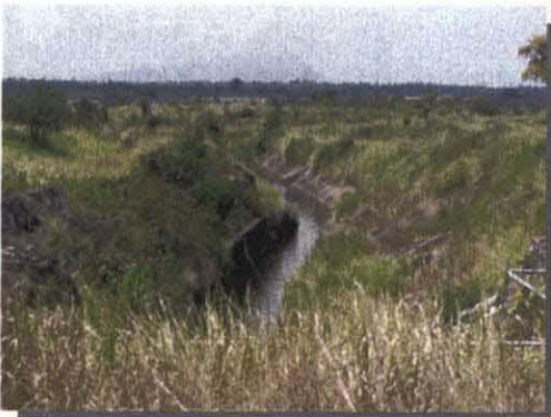
システム B 右岸スキームの主水路
