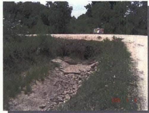
3次水路の破損状況
