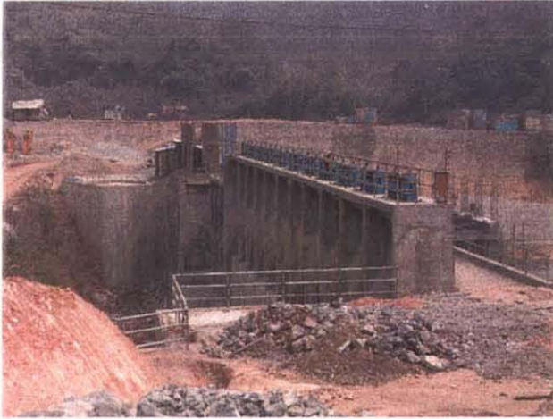
建設中の灌漑・発電用ダム（ルアンナムタ県）
