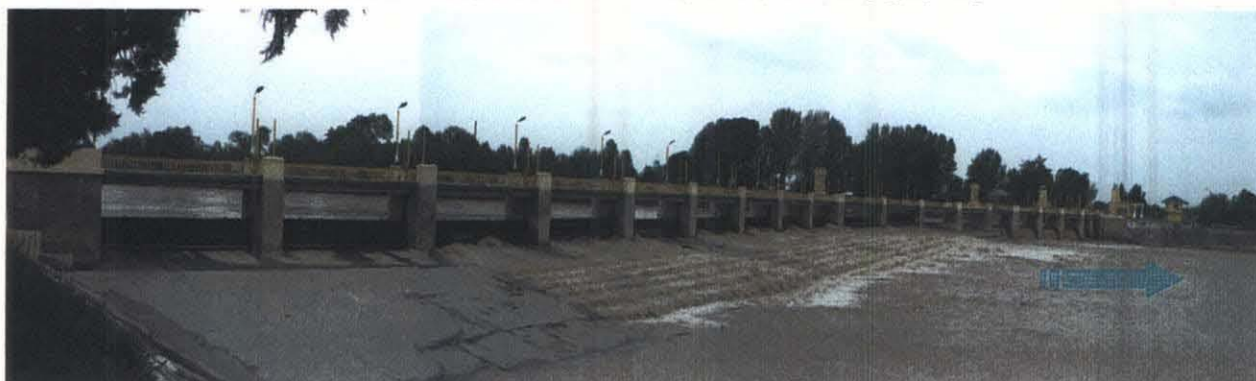
↑ Karadarya 川に設置された Kuiganyar 頭首工。写真右端より Great Fergana 運河への取水をしている。
