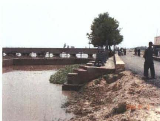
Vanike 支線水路：NDP 事業として堰の新設が予定されている。約 2 ft 嵩上げの予定。
