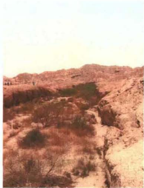
ダム堤体（写真上）は壊滅し、水路（写真右）は堆砂によって埋まり、取水口（写真下）は土砂で完全にふさがった（詰まった）状態である
