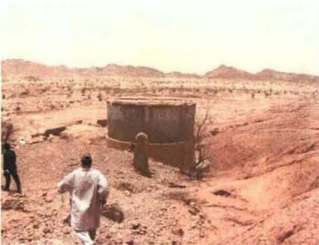
ダム堤体（写真上）は壊滅し、水路（写真右）は堆砂によって埋まり、取水口（写真下）は土砂で完全にふさがった（詰まった）状態である
