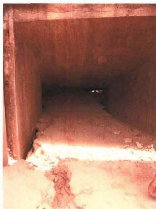
メイン水路につながる取水口の地下トンネルは完全にふさがってしまっている
