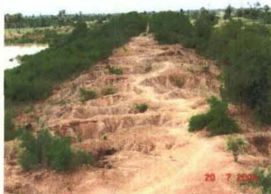
写真20:写真19の堤防の天端、浸食が激しいのは、施工上の問題があるようである。
