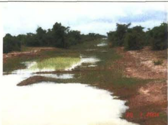
写真21:写真19から出ている水深の浅い幅の広い幹線水路、道路が横切る地点では閉塞している
