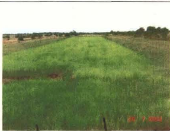
写真22:写真19から出ているもう一本の幹線水路であるが、原形をとどめていないばかりか苗代として利用されている。
