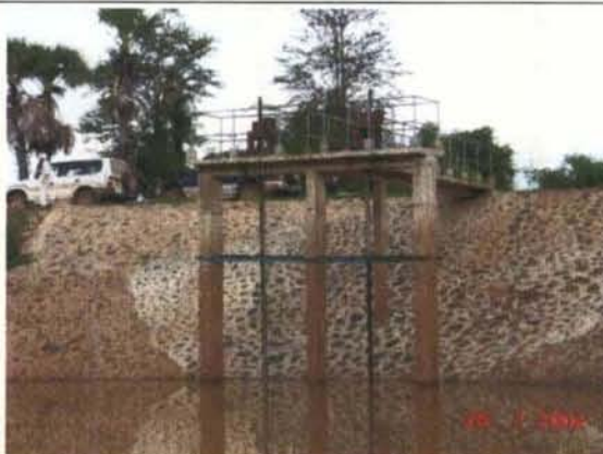
写真 16：PDWRAM が 2002 年に建設した水門
