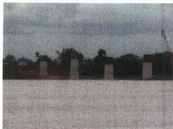
写真1：建設が進むメコン橋
