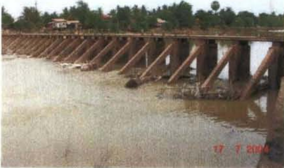
写真3：Pursat 川に建設された堰、水門と巻き上げ機が持ち去られている。
