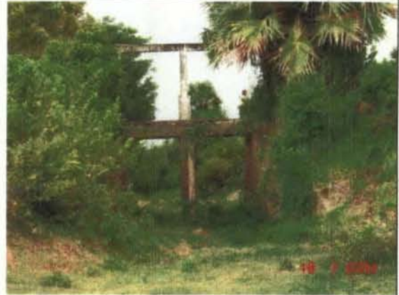
写真2：写真1の取水口、水門と巻き上げ機器が持ち去られている。構造物も再利用が難しい。
