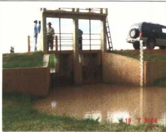
写真7: 世銀の援助により水門が建設され、堤防が改修されたため池。
