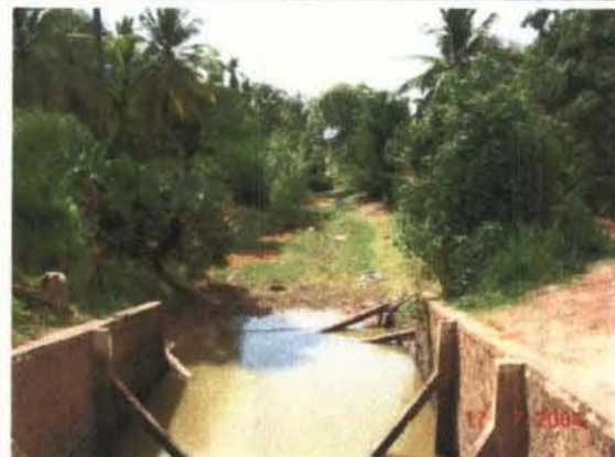
写真6：写真5の取水口からつづく幹線水路、堆砂と法面の崩壊により水路は埋没している。
