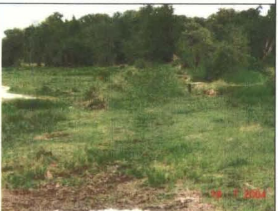
写真12: 写真11から出ている用水路であるが、原形をとどめていない。
