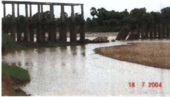
写真1：Pursat 川に建設された取水堰
