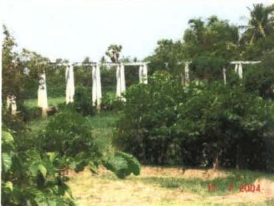
写真5：Pursat 川の最下流にある堰、通水部は完全に埋没している。
