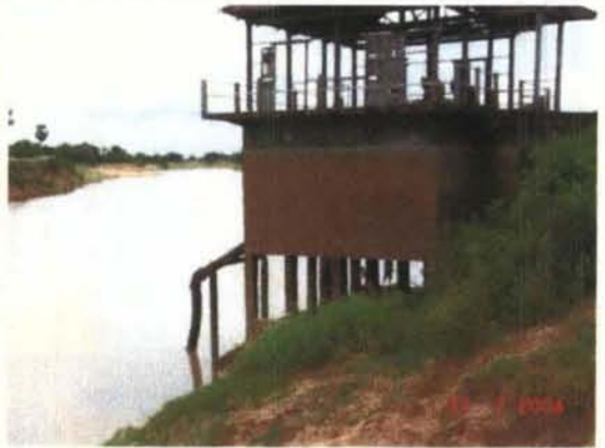
写真 18：クメール・ルージュ時代に造られたポンプ場、ポンプ等全ての機器は持ち去られている。
