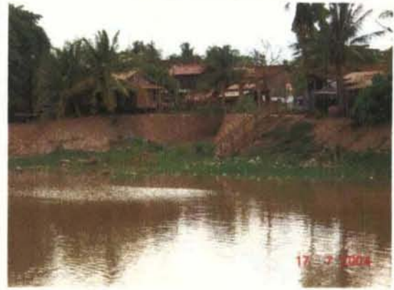
写真4：写真3の取水口、ほとんど機能していない。
