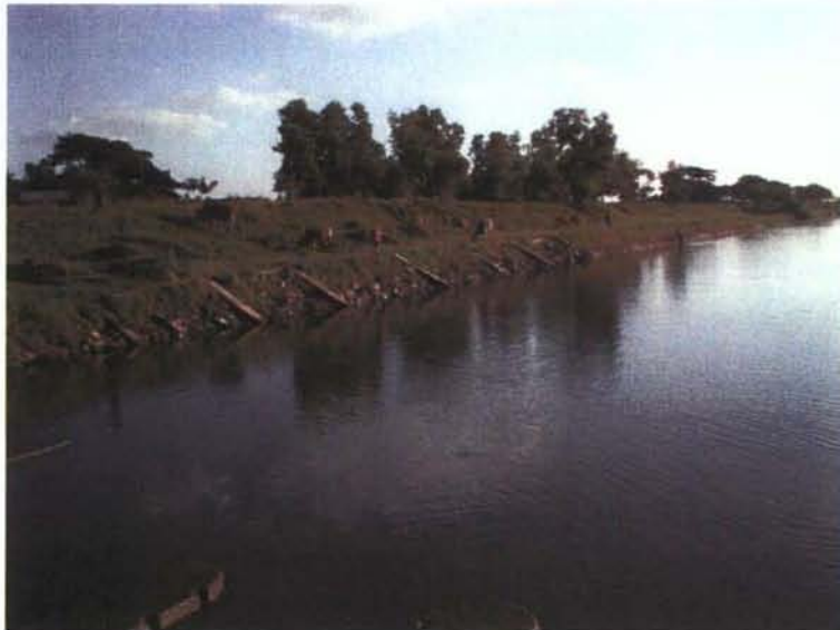
道路と並行して走る幹線排水路 通水能力はありと考えられる。
