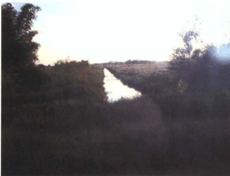
幹線排水路に接続する支線排水路 水路密度、延長とも不足している。
