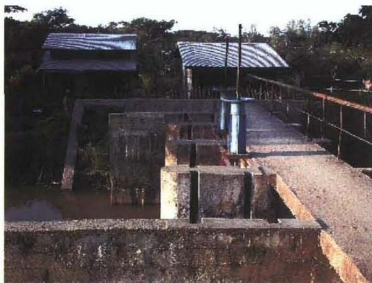
同上（上流より見る） 2 m × 2.5 m のスルースゲート 4 門
