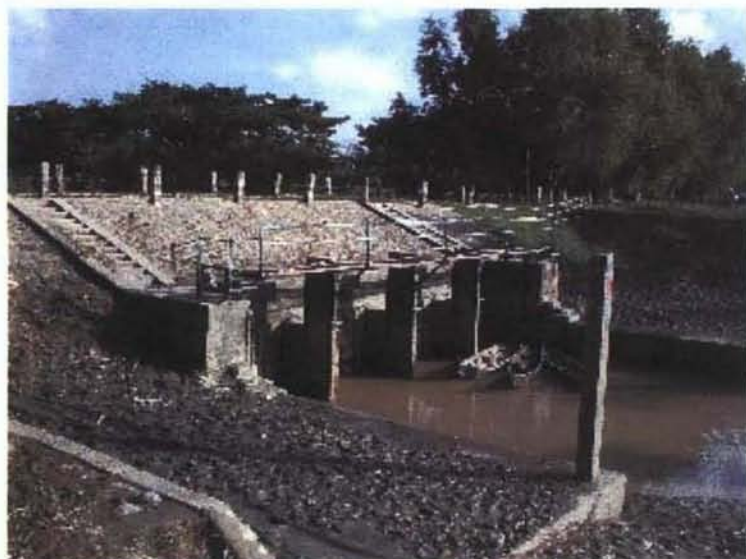
地区内より Hlang 川への排水樋門（下流より見る） 2 m × 2 m のフラップゲート 4 門 16,000 ha の配水施設として能力不足である。
