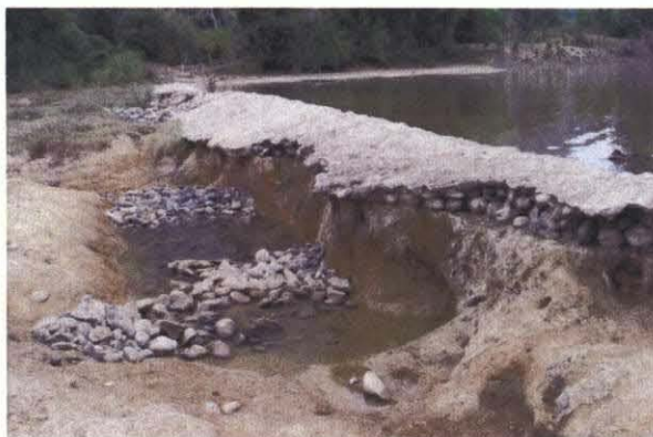
既設小規模ダム
