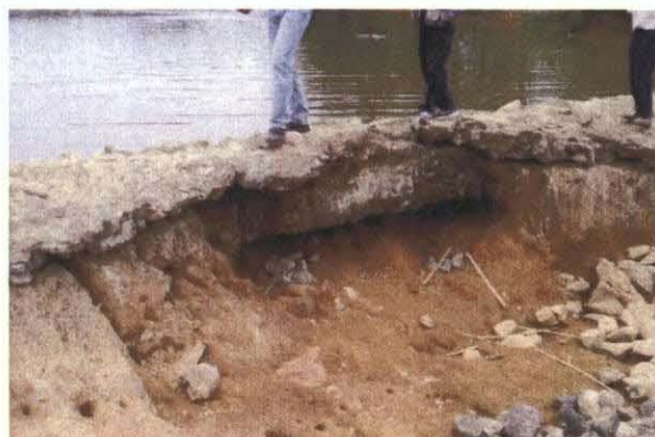
既設小規模ダム
