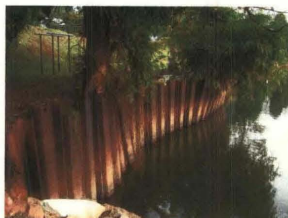
護岸工ケラニ洪水防御事業（コロombo県）
