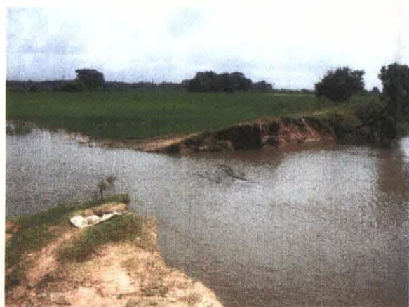
決壊した洪水防御堤（トリンコムレ県）
