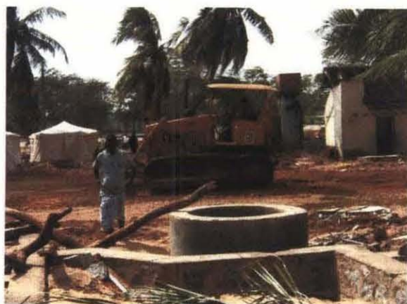
処理作業 (アムパラ県) Clearing of damaged area (Ampara)
