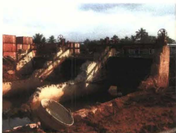
ラジアルゲート付け替え工事 ケラニ洪水防御事業（コロombo県）
