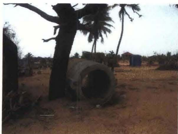
飲料水用井戸の被害 (アムパラ県) 津波の直前にパ化ンク発生。帯水層への海水混入の可能性大 Damage of drinking well (Ampara)
