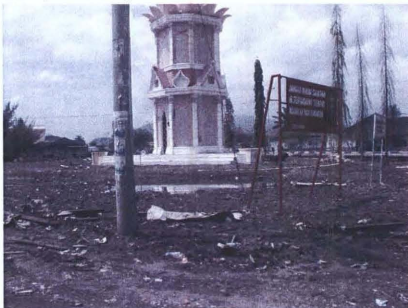
【現地の被害状況（1／14）】
