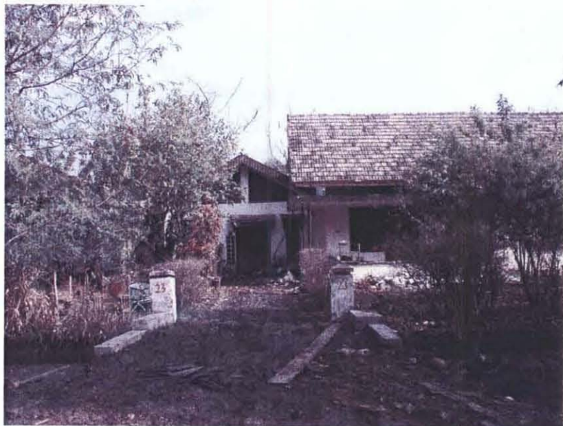
【現地の被害状況（14／14）】
