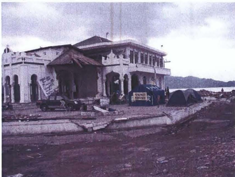
【現地の被害状況（8／14）】
