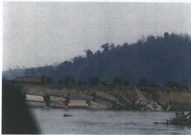
洪水により破壊されたコク川中流左岸 (メイサイ川よりの導水路はコク中流大堰に連結するのでコク中流左岸は洪水防御 のための護岸工事を1.0～1.5kmにわたってする必要がある)
