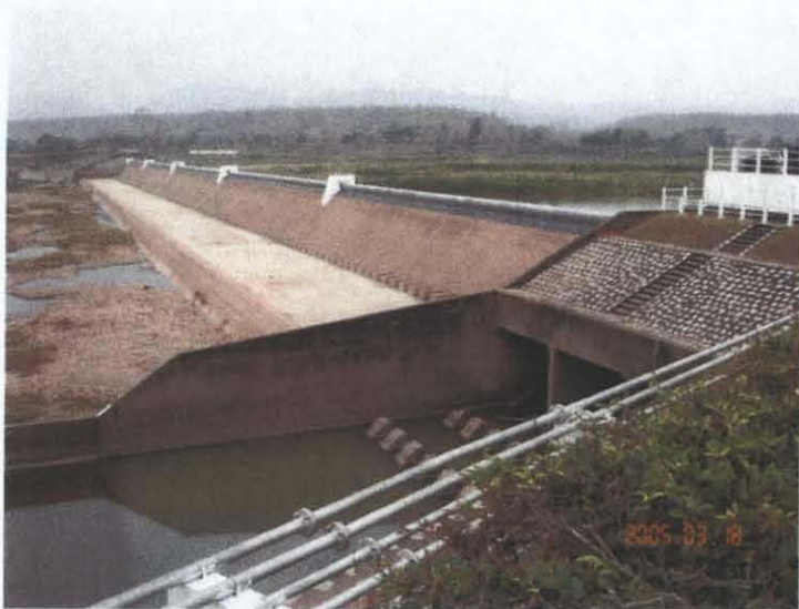
ヨム川に建設されたラバーダム。 乾季、干ばつにより上流には水は少ない。
