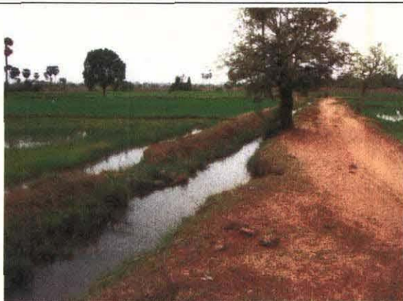
写真3: 限られた地域では、農民が独自に行う幹線水路からのポンプ給水により末端水路の一部には乾期でも水があふれており、灌漑農業が営まれている。
