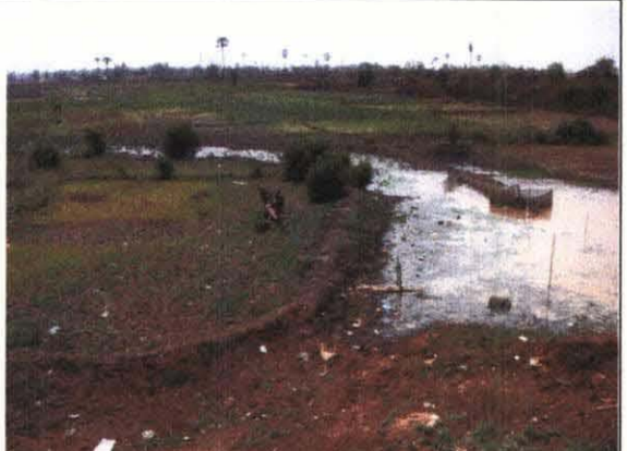
写真12: 草の根無償により建設されたため池。農村連絡道路と幹線道路により堤を形成。洪水被害を軽減し、灌漑用水を供給している。
