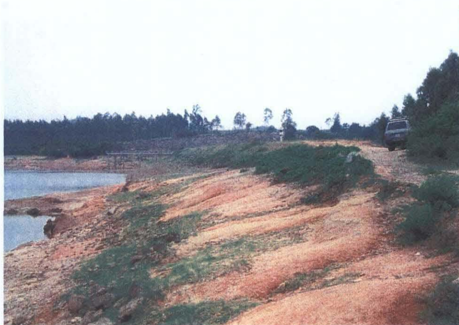
An Tho 貯水池 (1938 年完成) 河床部地山で多数のボーリング跡が見られる。 V=1,300,000\text{m}^3 , H=10.6\text{m}
