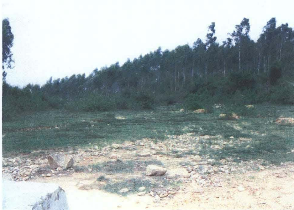
洪水吐は修理されたが、放水路は未整備である。下流 1.5km には鉄道、2.5km には町がある。
