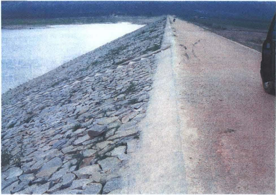
Ong Toi 貯水池(JBIC SPL4 で 2005 年に改修された)
