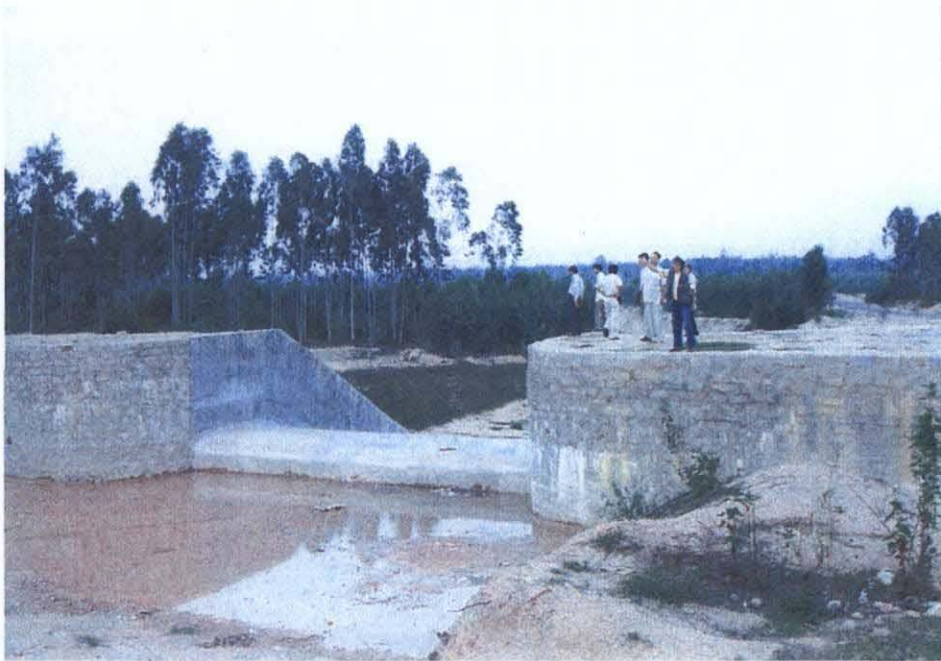
改修された余水吐
