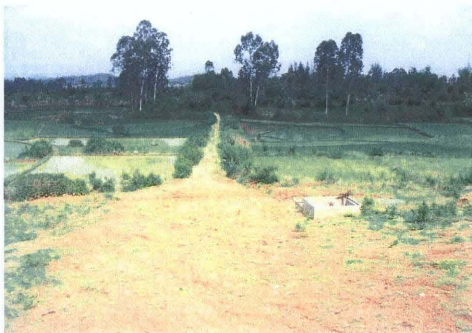
改修された底樋の吐水槽
