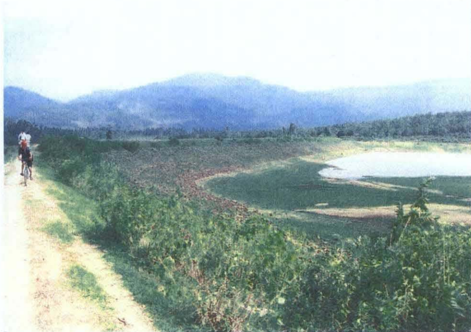
Mach Dieu 貯水池（1983 年完成）堤体から広範囲にわたり漏水が発生している。 V=1,350,000\text{m}^3 , H=12\text{m}
