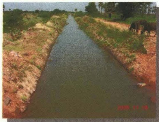
NH 水路 (NH Channel) コマムール水路からの支線水路。 石積みがなされているが崩壊が進んでいる。
