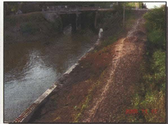
レイベス水路の決壊箇所 緊急工事により Side Wall が造られた
