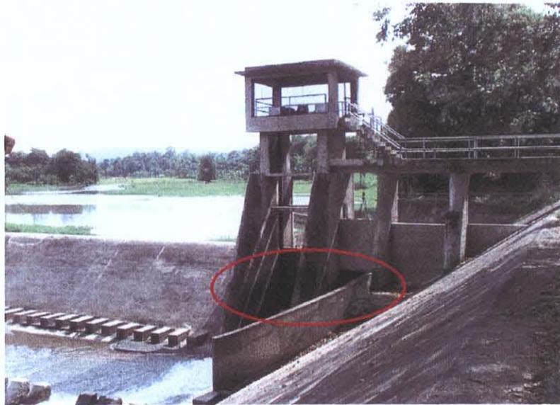
Figure 3. 1997年に改修された Marbel River No.1 頭首工（左岸下流から）。赤で囲んだ部分にタービン発電機を設置する候補箇所。ゲートや巻上げ機は、よく維持管理されていて問題なく稼動するが、固定堰上流部は堆砂で埋まってしまっている。
