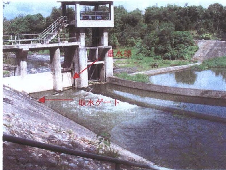
Figure 4. 1997年に改修された Marbel River No.1 頭首工（左岸上流から）。頭首工直上流の左岸法面に取水ゲートが2門ある。取水量は、量水標で測っているとのこと。導流壁と取水ゲートの間に幹線水路への土砂の侵入を防ぐための越流壁設けられている。
