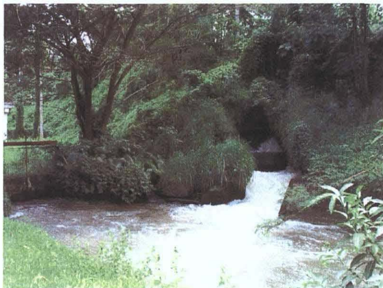
Figure 2. 用水の迂回路出口。現在は発電を実施していないので、用水を迂回させて、発電施設の直下流で幹線水路に合流させている。写真左手奥に発電設備棟がある。
