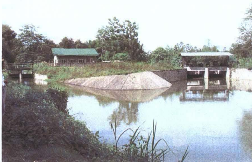
Figure 8. 頭首工の 500m 下流にある沈砂池。左側が幹線水路で、右側が Marbel River に通じる排砂門。排砂時は、幹線水路の側の水門を閉じ、エンジン式ウィンチで排砂ラディアルゲートを開ける。
