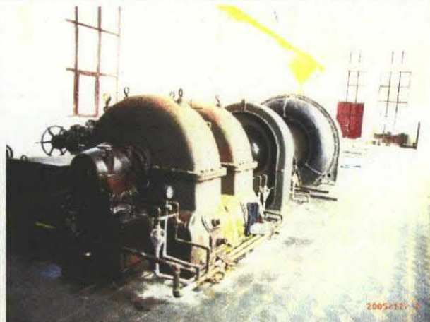
シェキ市水力発電所
