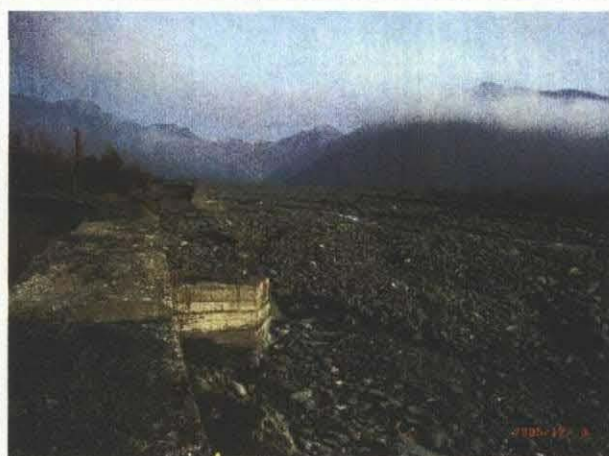
土石流防御用護岸工
