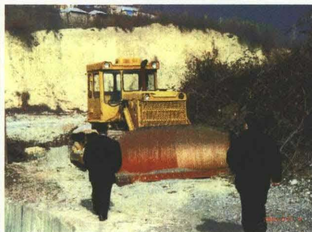
河道形成用ブルドーザー
