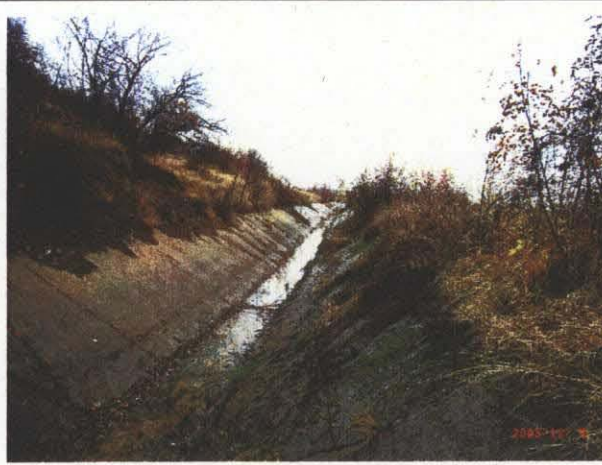
スレドナツンジャ地区灌漑支線水路
