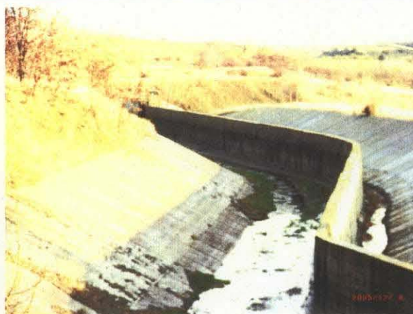
スレドナツンジャ地区幹線水路
