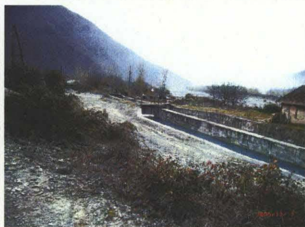
シェキ市水力発電・水道取水口
