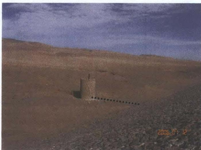
写真中央はダム上流に建設された立樋で口径100mmの鋼管が堤体底に敷設され下流へ導水され灌漑用水として利用される。
