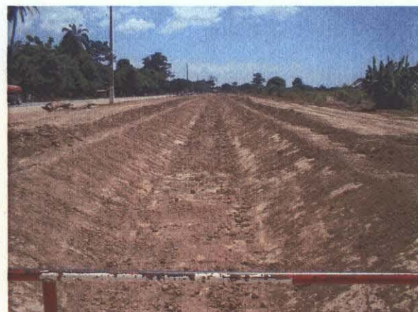
Caxito 市 アンゴラ政府による用水路建設工事
